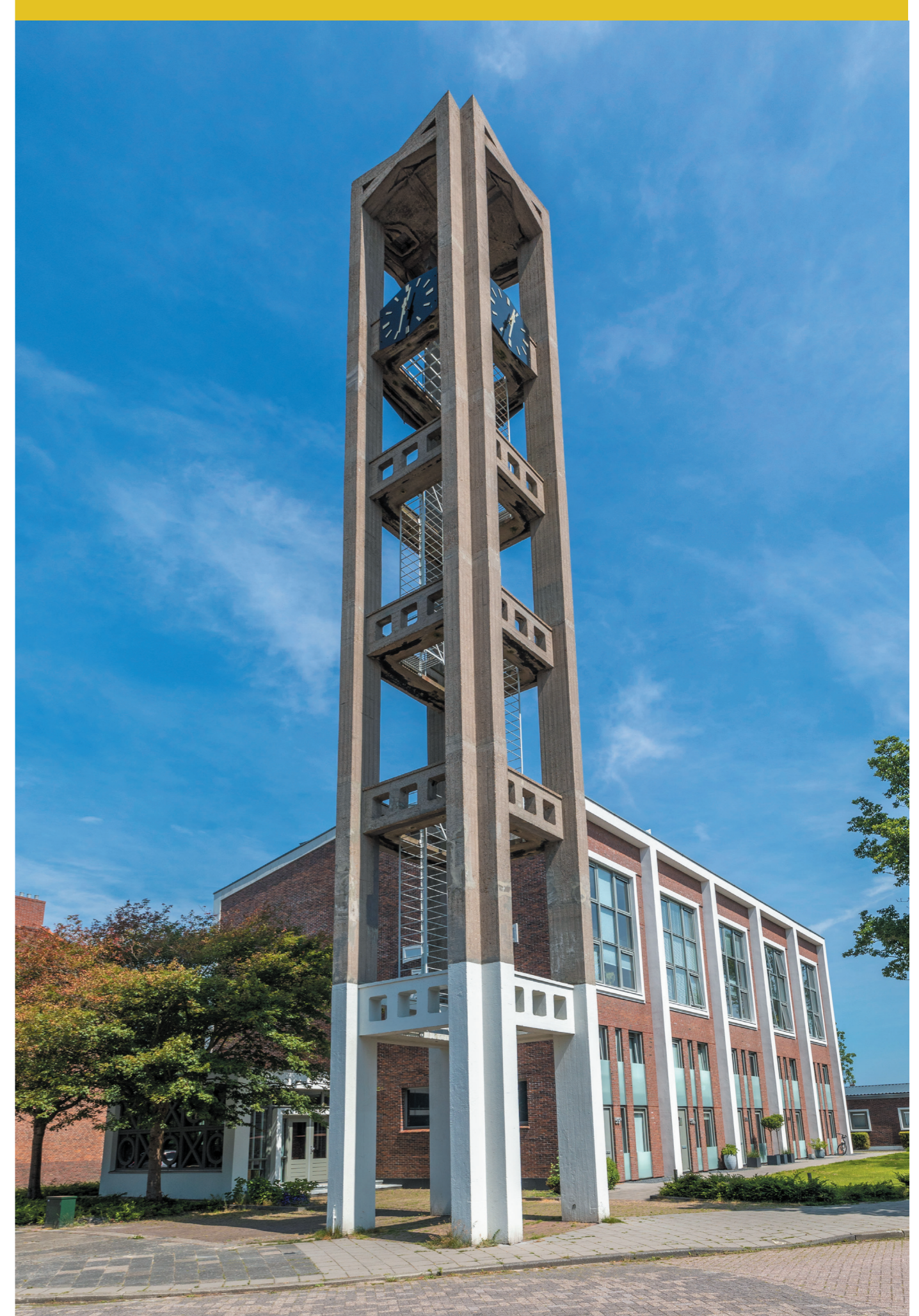
De vrijstaande toren van de Opstandingskerk is een belangrijk architectonisch en stedenbouwkundig element en is daarom aangewezen als gemeentelijk monument.
