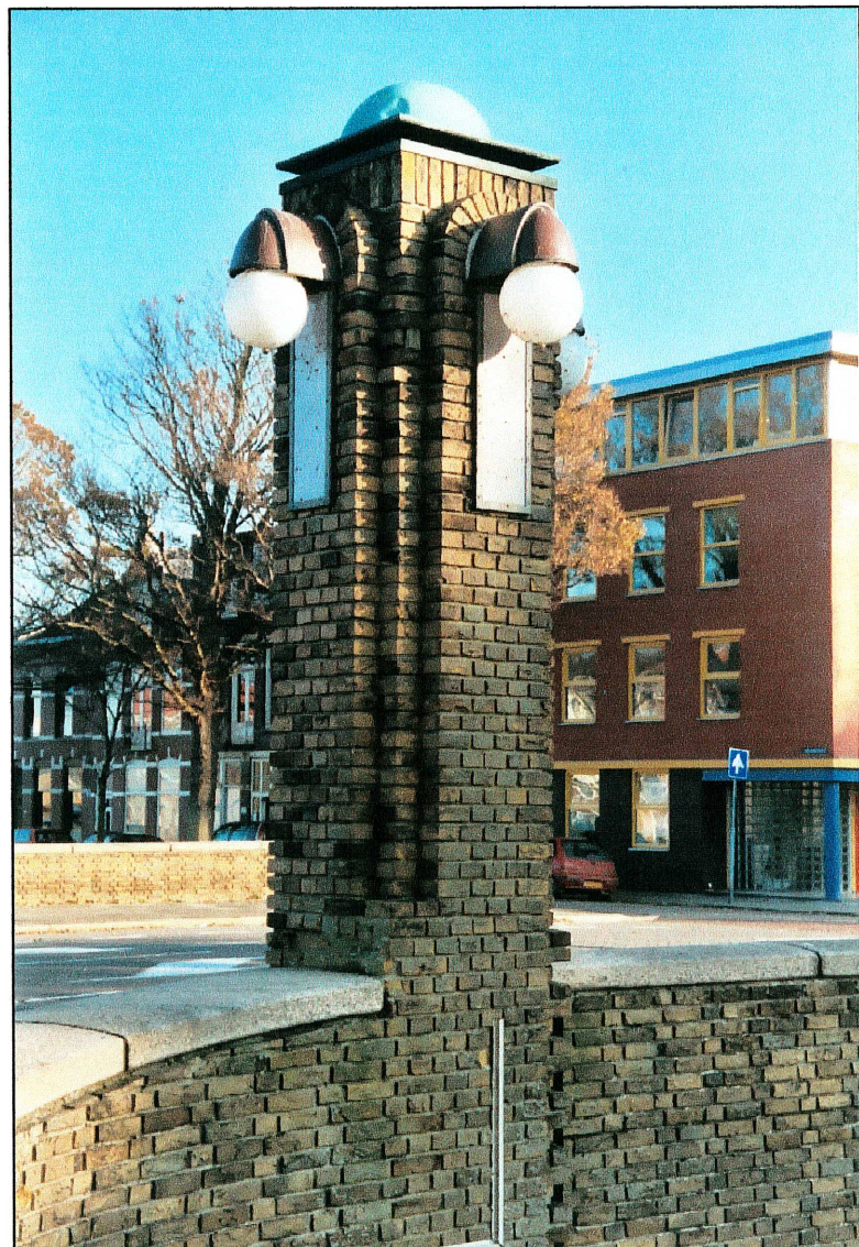
Afb. 6: Het zogenaamde Noordse verband waarin de gemeleerde bakstenen van de Postbrug zijn gemetseld.
