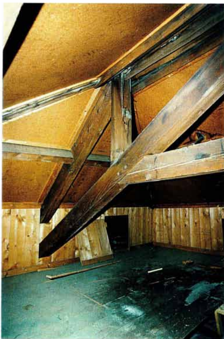
Afb. 8 Detail van de kapconstructie: bij de verhoging van het pand in 1914 is de oorspronkelijke constructie hergebruikt. De kleine dakschilden op het westen en oosten werden echter steiler uitgevoerd, waardoor een verlende nokgording nodig werd, plus de bijbehorende nokstijl.
