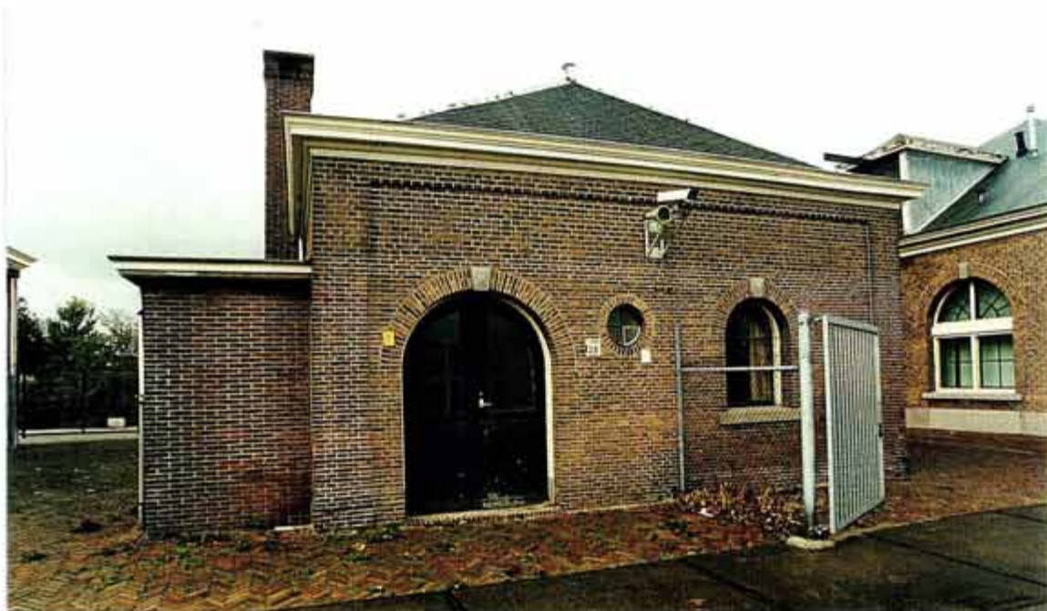
Afb. 4 (boven) Gebouw 28 vanuit zuidwesten. De ramen in de westgevel dateren uit 1914, de aanbouw aan de zuidzijde is in 1947 gebouwd. Het grote driedelige venster is van recentere datum, het rechter venster is verplaatst en het wc-raampje ingezaagd.
