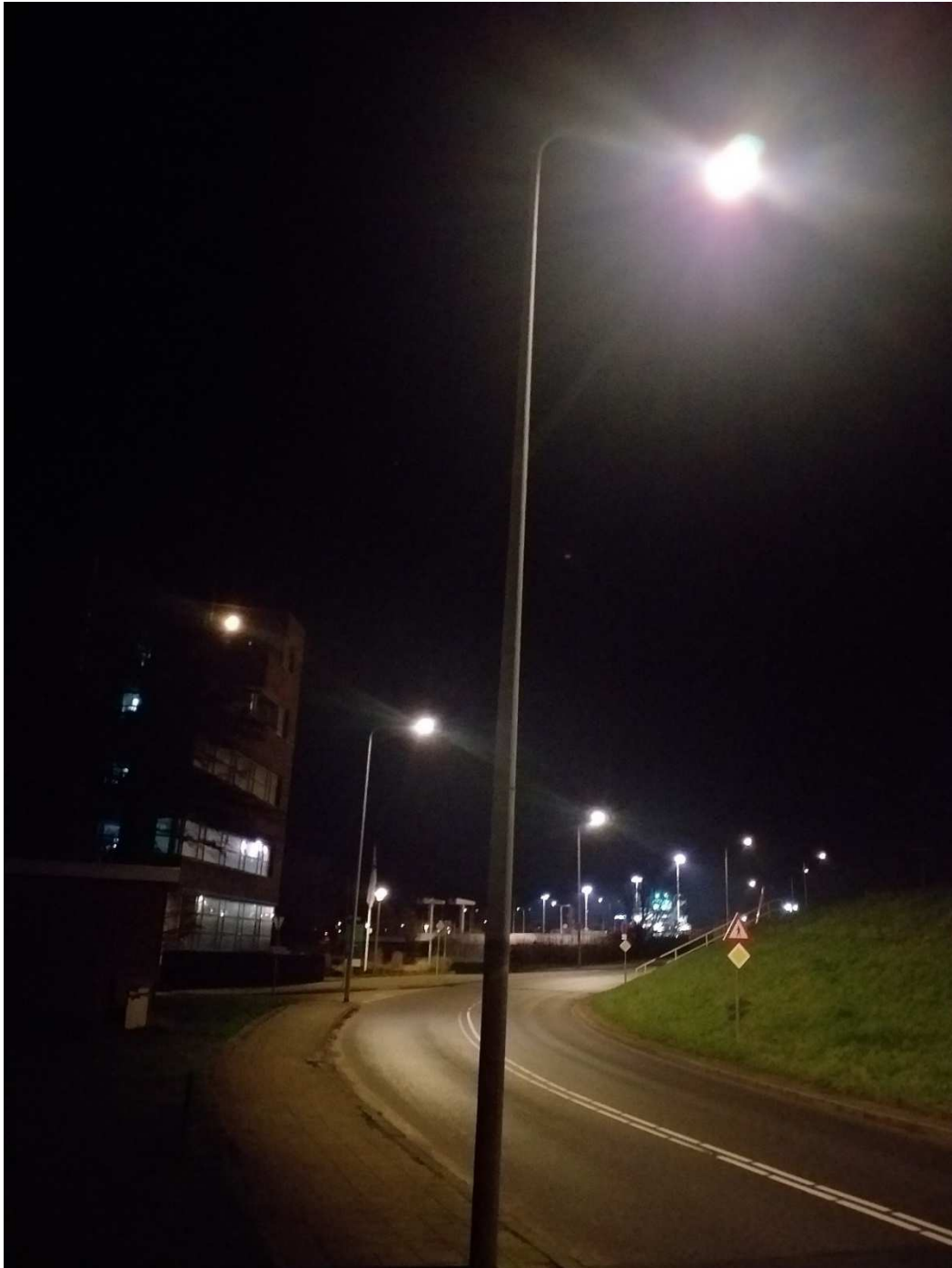
Figuur: voorbeeld van een lichtmast langs een weg tijdens de avonduren
