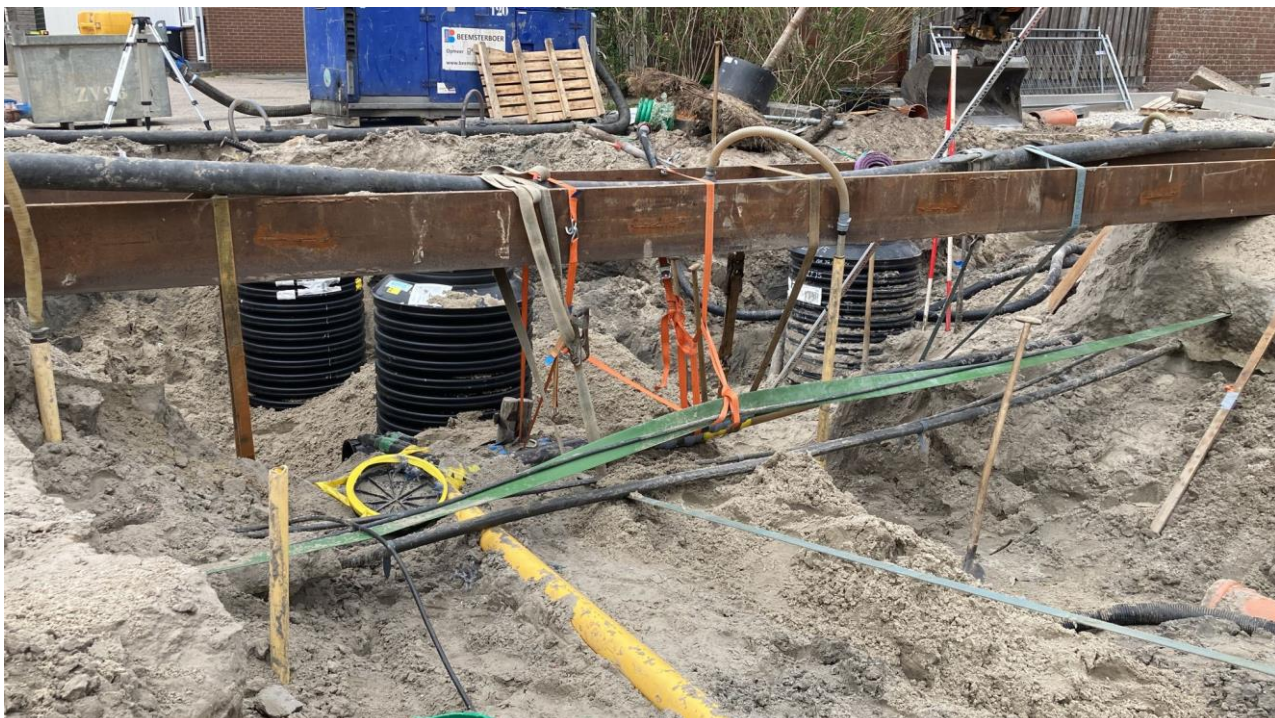
Figuur 7-1: Rioolwerkzaamheden in Den Helder
