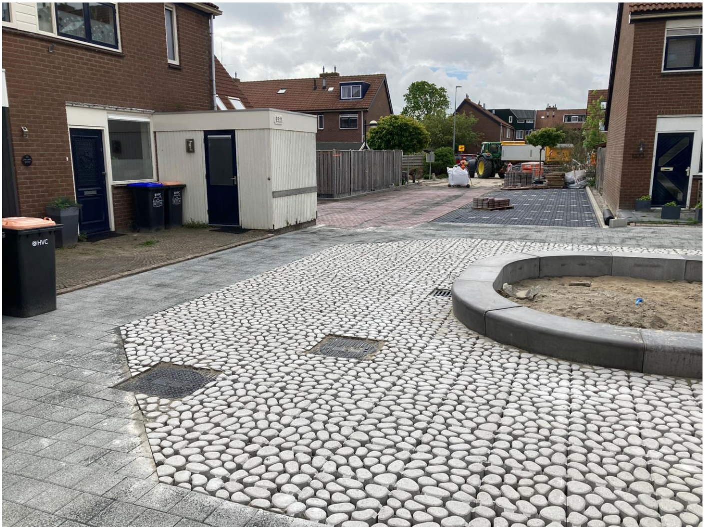
Figuur 8-1: Doorlatende verharding in Den Helder
