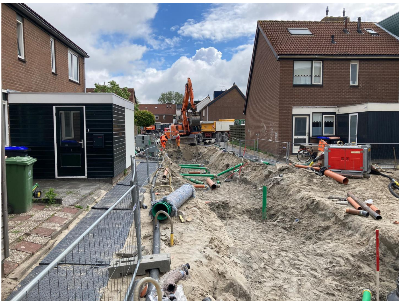
Figuur 8-6 Riolverkzaamheden in Den Helder
