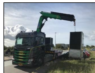
Afbeelding: Plaatsing cameramasten station Zuid
