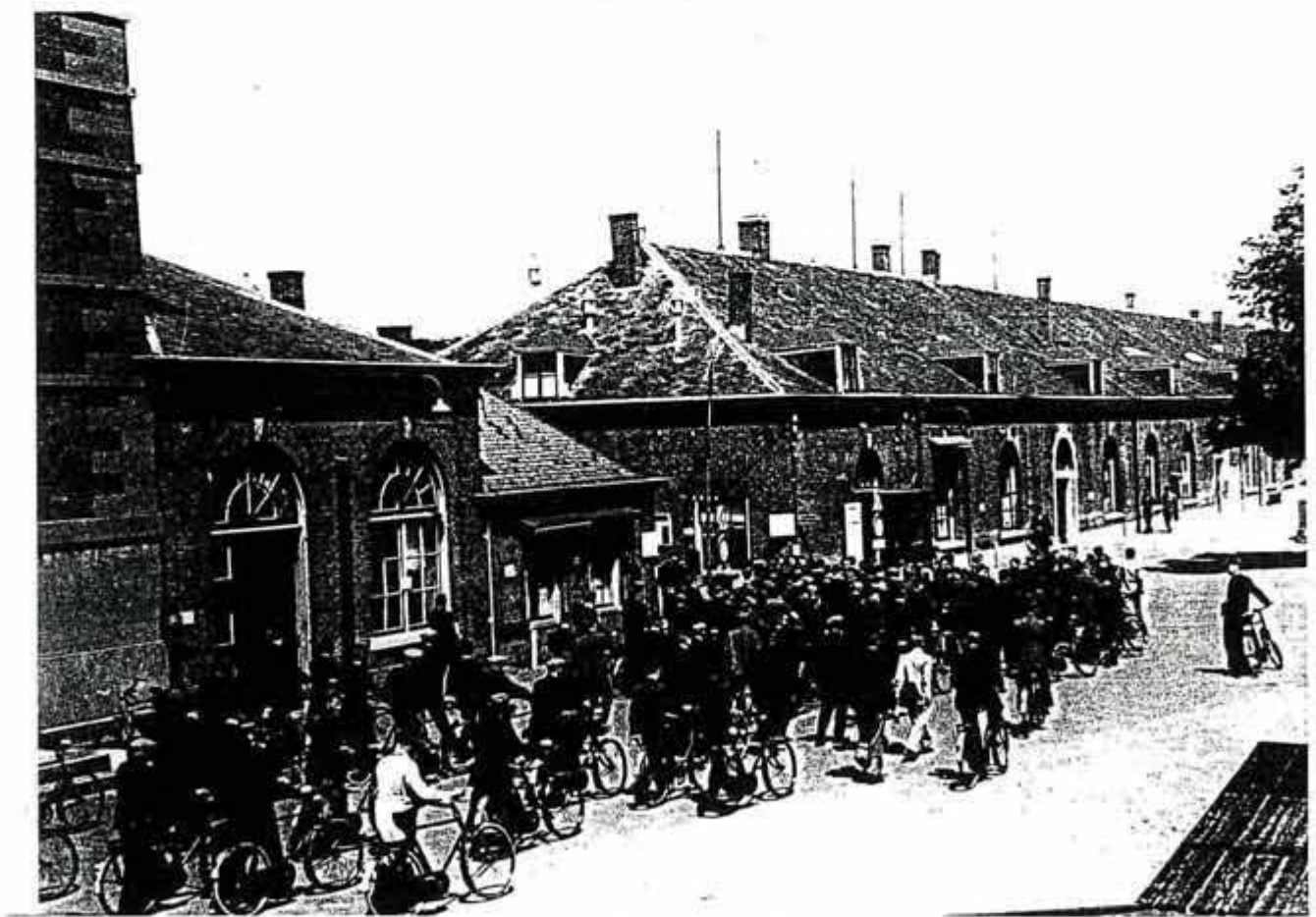
Afb. 17 De oostzijde van de beide noordelijke aanbouwen vóór 1939. Links is de oorspronkelijke uitmonstering van de oude kern van gebouw 47 zichtbaar. De aanbouw tegen deze kern is in 1838 gebouwd tussen de kern en de rechtse aanbouw uit ca. 1823. In 1939 werd de hogere aanbouw verbouwd tot brandweergarage (zie afb. 7). (Herkomst: Instituut voor Maritieme Historie)
