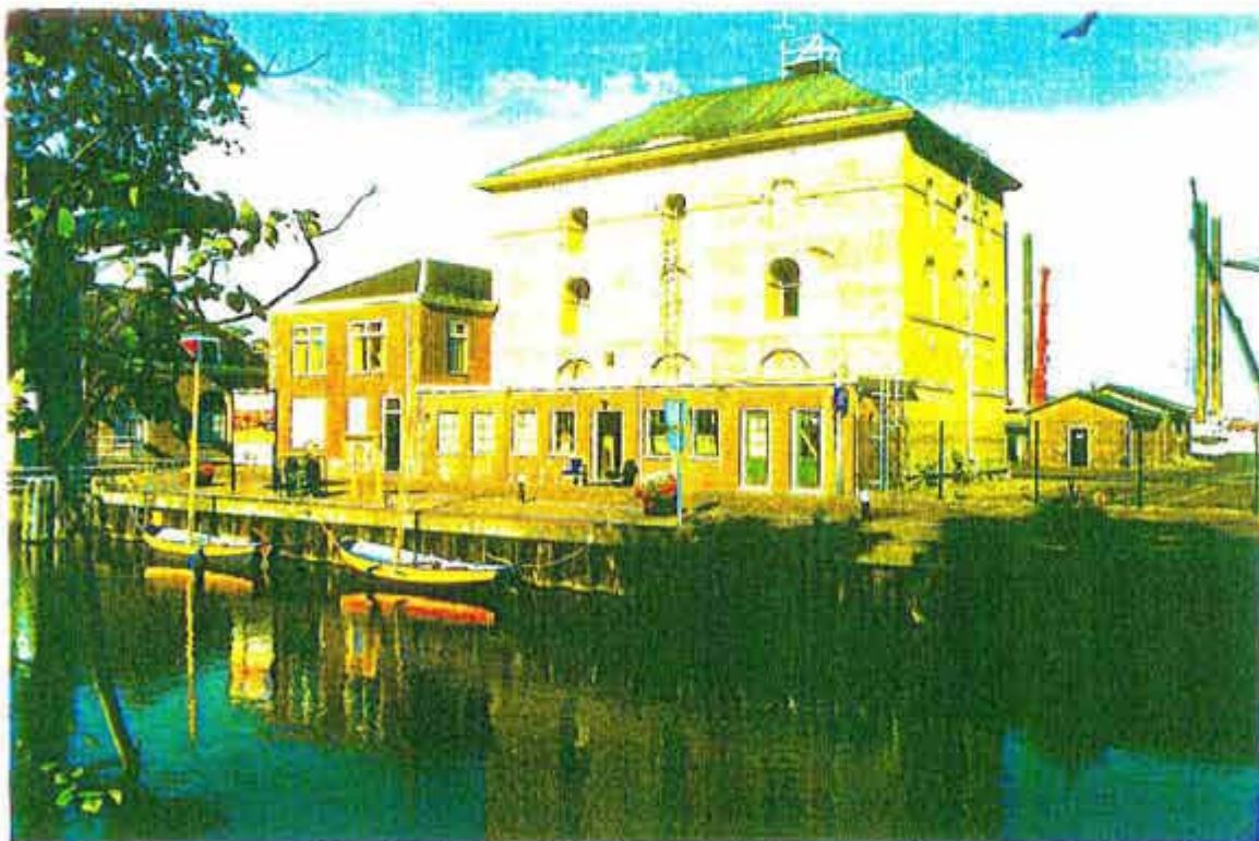
Afb. 25 De westgevel van gebouw 47, de westelijke aanbouw en het wachthuis. Het hoge bouwdeel uit 1815/1816 in 'Rundbogenstil' heeft een deel van de oorspronkelijke uitmonstering behouden (zie afb. 24). In 1939 is tegen de westgevel van dit bouwdeel een lage aanbouw gemetseld, in een sobere neo-classicistische trant (afb. 8). Het hogere bakstenen wachthuis aan de noordzijde van het hoogste bouwdeel is in 1966 gebouwd (afb. 12 en 13).
