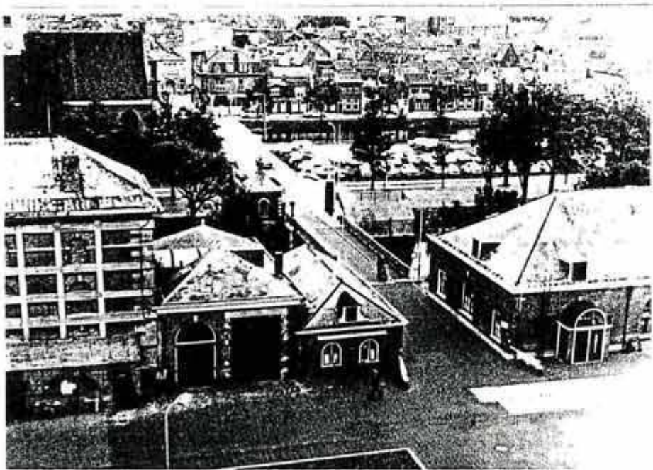
Afb. 18 De oostzijde van de oude kern (deels) van gebouw 47 en de beide noordelijke aanbouwen, kort vóór 1966. Tegen de oude kern is het betonnen 'korset' zichtbaar, dat in de Tweede Wereldoorlog (1943?) zal zijn aangebracht. Het betonnen 'voorportaal' tegen de begane grond is met zekerheid in 1943 gerealiseerd (afb. 10). De hoge aanbouw toont de in 1939 aangebracht hoge deur voor de brandweergarage (afb. 7). De lage aanbouw is niet gewijzigd. De beide aanbouwen werden in 1966 afgebroken voor de nieuwbouw van het wachthuis (afb. 12). (Herkomst: Archief Rijkswerf)
