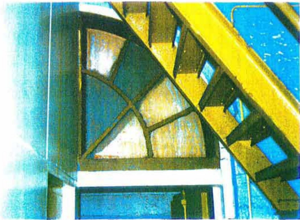
Afb. 35 De begane grond van gebouw 47. De zuidelijke deuropening in de oostgevel heeft de oorspronkelijke roedenverdeling van het halfronde bovenlicht uit 1815/1816 behouden (vergelijk met afb. 4).
