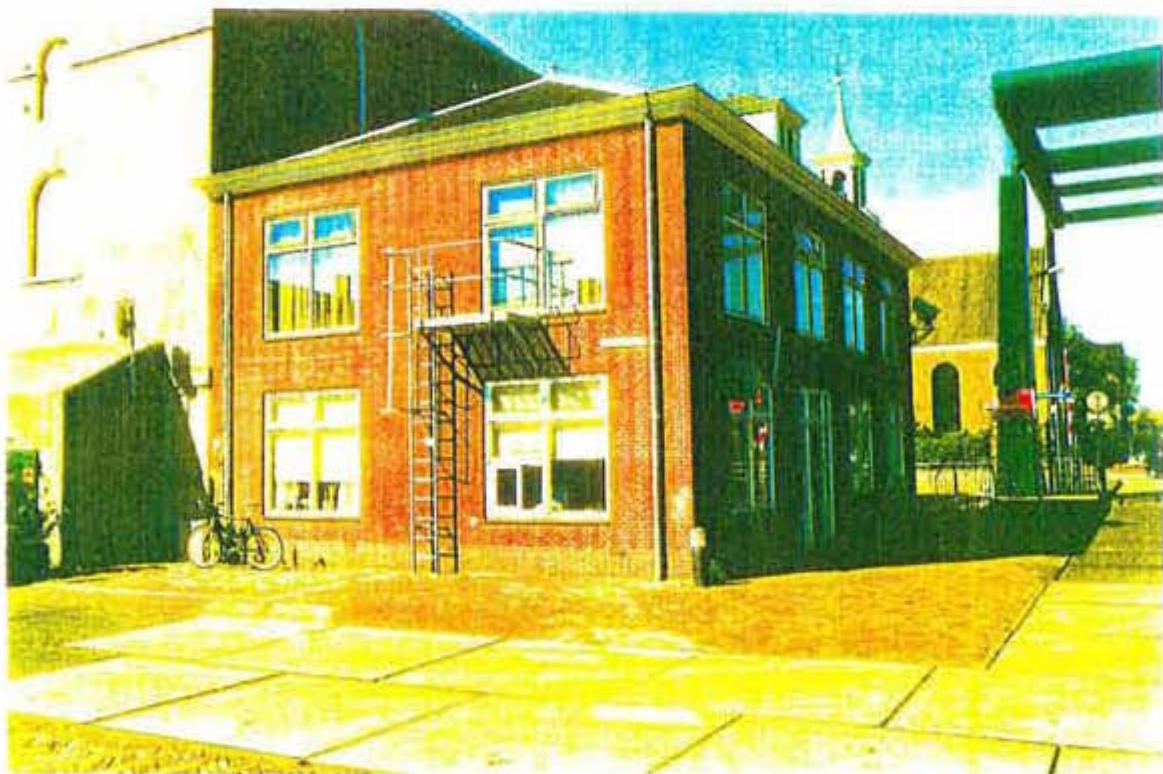
Afb. 31 De oostgevel van het wachthuis uit 1966 (afb. 12 en 13). De opzet is identiek aan de westgevel; hier bevinden zich twee traveeën. De onderverdeling van het rechter venster op de begane grond (in het linkerraam bevindt zich een klein venster van twee ramen, waarvan het linker geopend kan worden) is later aangebracht.
