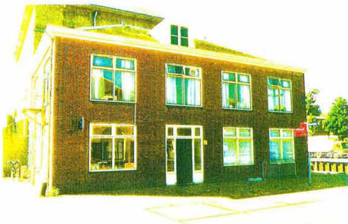
Afb. 30 De noordgevel van het wachthuis uit 1966 (afb. 12 en 13). De gevel is decoratief in strak Noords verband gemetseld: afwisselend twee strekken en één kop in elke laag. De brede vensters in de vier traveeën bestaan uit 2x2 ramen, waarvan de bovenste geopend kunnen worden. De toegang in de tweede travee bestaat uit een 'melkmeisje': de deur wordt geflankeerd door twee smalle vensters en bekroond door drie bovenlichten in dezelfde opzet. Deze travee is op de kap voorzien van een dakkapel.
