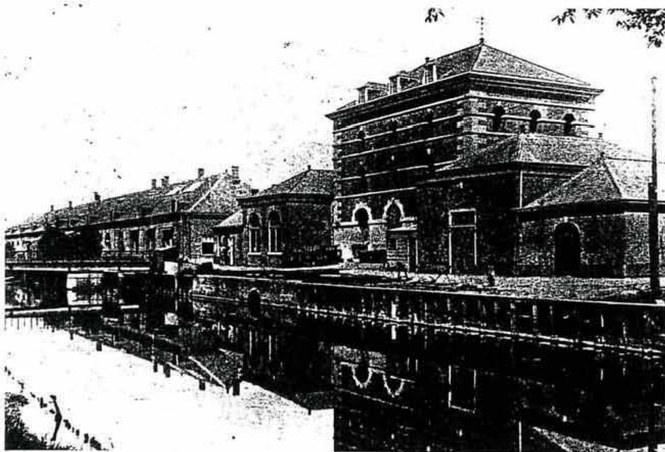
Afb. 20 Aanzicht vanuit het zuidwesten van het complexe gebouw 47. De oude kern bezit nog de oude uitmonstering. Het afsluitingskanaal heeft ter plaatse van het oude Pomphuis een bakstenen beschoeiing waarin de uitlaat van het pompwater is aangebracht.
