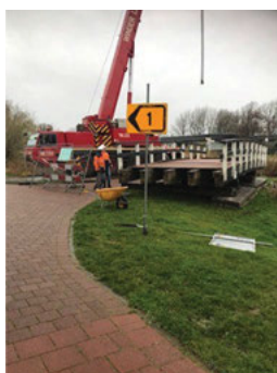
Foto: Brug nabij Galjoenstraat. Brug is ingekort en heeft nieuwe opleggingspunten.
