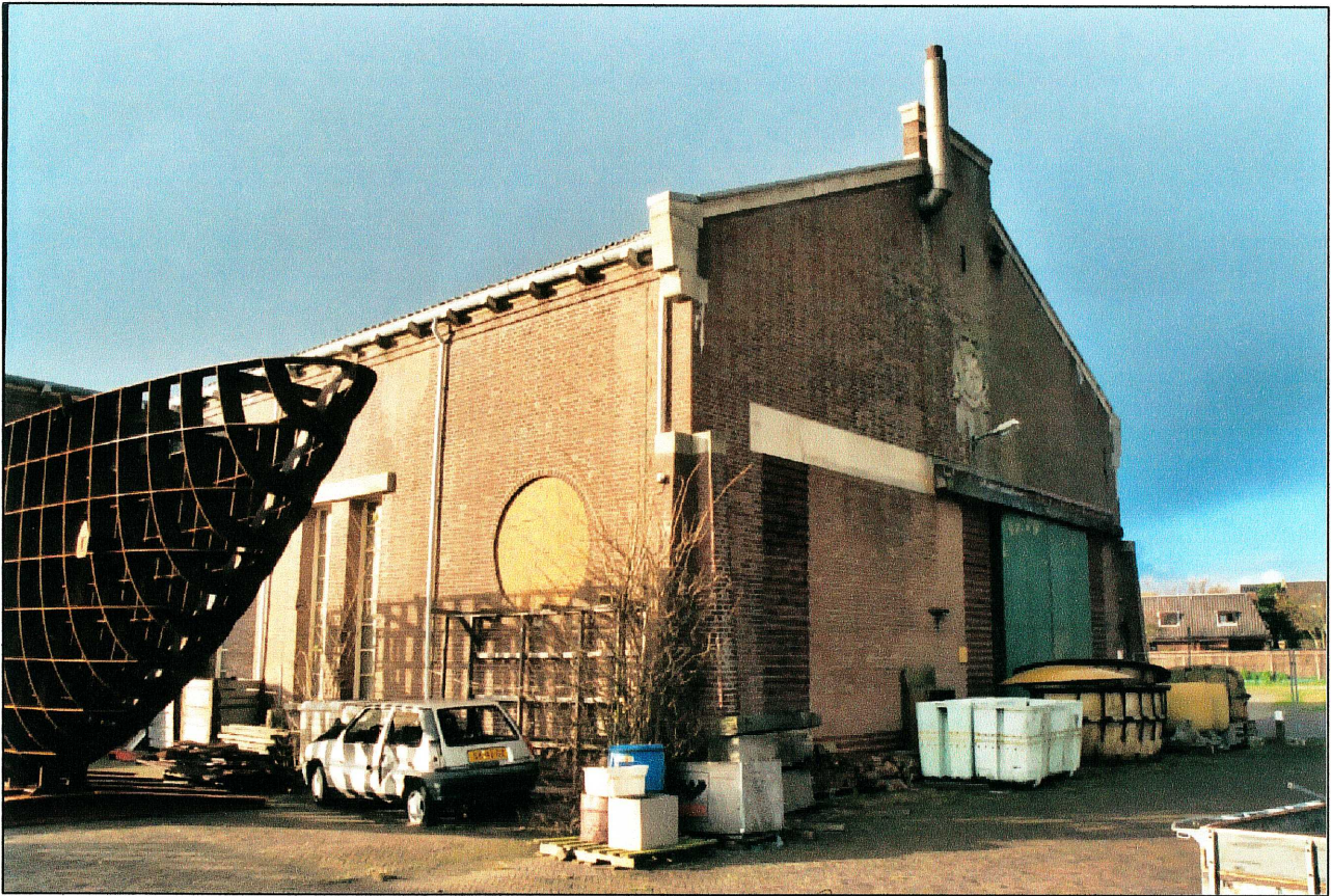
Afb. 19. De voorgevel van de loods.
