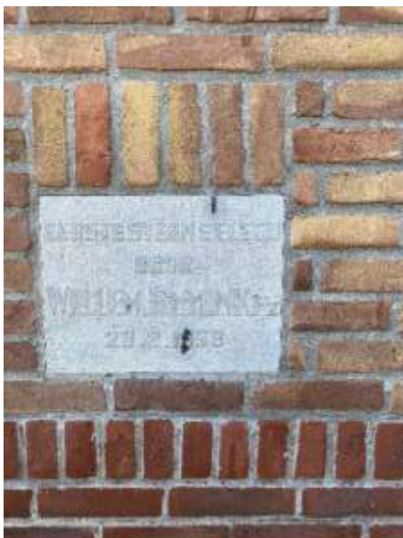
Afbeelding 8: Gevelsteen voor de herbouw (2021)
