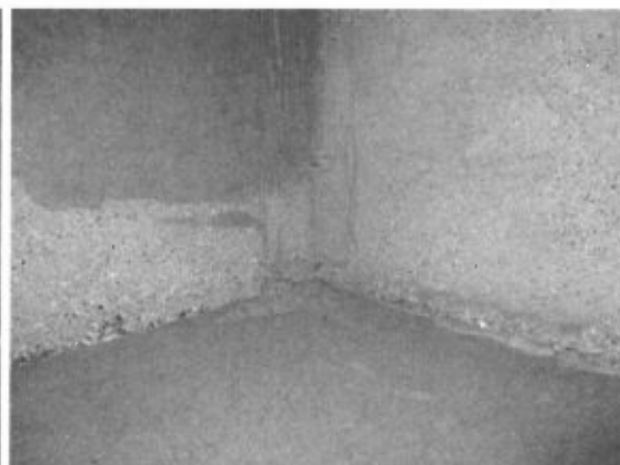
Figuur 4.10: Vloer-wandaansluiting met gepleisterd wandoppervlak
