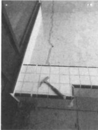
Figuur 4.5: Kitvoeg nabij gevel en doorgang
