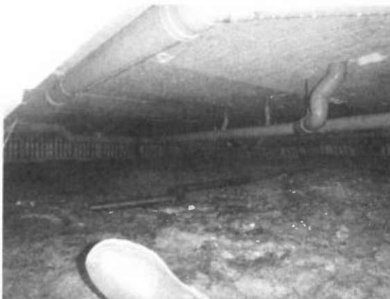
Figuur 4.17: Kruipruimte onder kleedruimten
