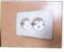
Type: Schuko met 2 polen, 230V, 16A
