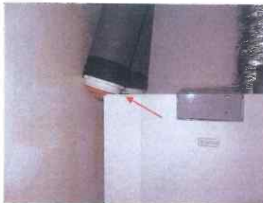
Doorvoeren WTW dichtgezet
