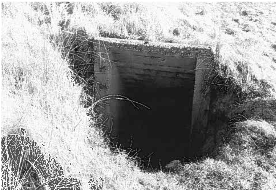
82 Den Helder-Huisduinen, Stelling van Den Helder, dubbele kanonkazemat ± 1916 (in situatie nr. 5), ingangszijde naar O, foto 1986.
