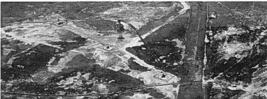
93 Den Helder-Huisduinen, Stelling van Den Helder, Batterij Helsdiep, overzichtsfoto met drie geschutemplacements c.a., alsmede een niet meer bestaande uitkijktoren.
