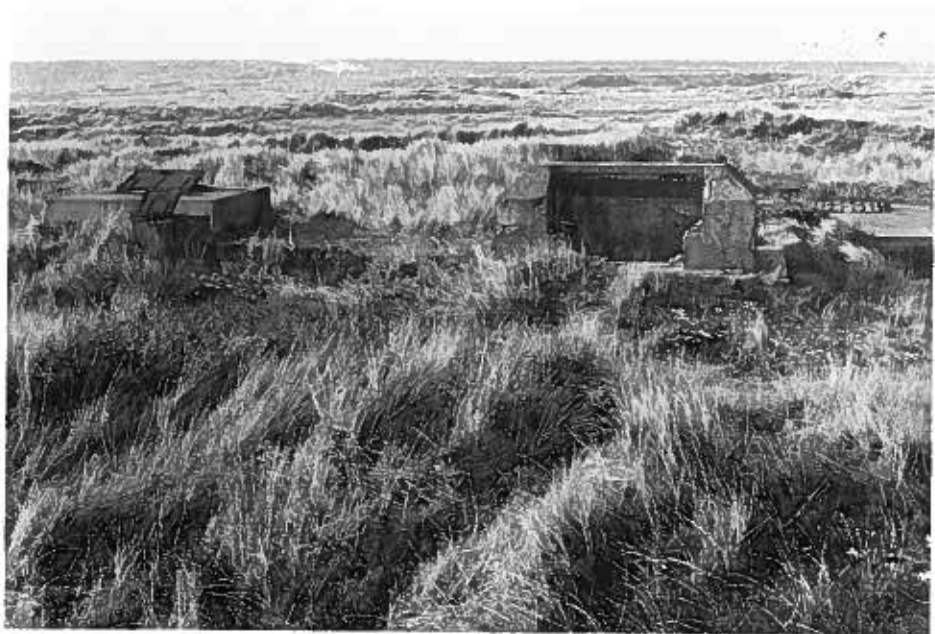
102 Den Helder-Huisduinen, Stelling van Den Helder, Batterij Helsdiep, middelste emplacement en munitiemagazijn (in situatie nr. 10), naar W, foto 1986.
