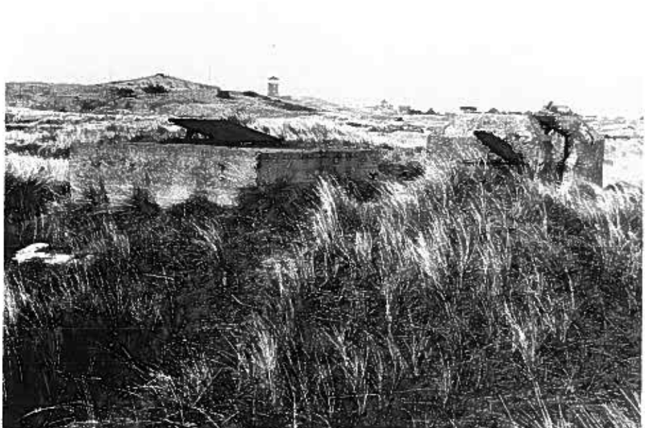
103 Den Helder-Huisduinen, Stelling van Den Helder, Batterij Helsdiep, middelste emplacement en munitiemagazijn (in situatie nr. 10), naar N, foto 1986.
