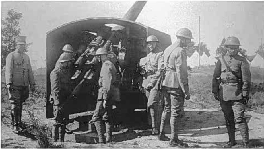
92 Den Helder-Huisduinen, Stelling van Den Helder, vuurmond van 10TL in vaste opstelling, zoals deze aanwezig was op de open bedding voor luchtdoelgeschut bij Huisduinen.
