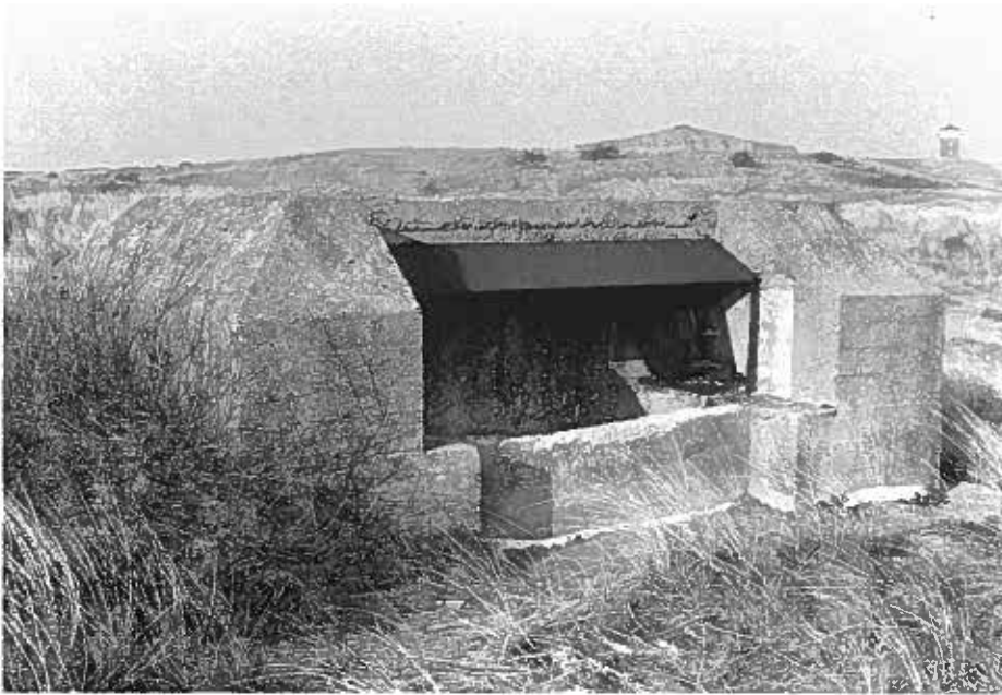
100 Den Helder-Huisduinen, Stelling van Den Helder, Batterij Helsdiep, noordelijk emplacement en munitiemagazijn (in situatie nr. 9), munitielift naar W, foto 1986.
