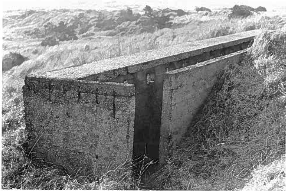
89 Den Helder-Huisduinen, Stelling van Den Helder, zuidelijke loopgraaf, ± 1916 (in situatie nr. 7), naar Z, foto 1986.
