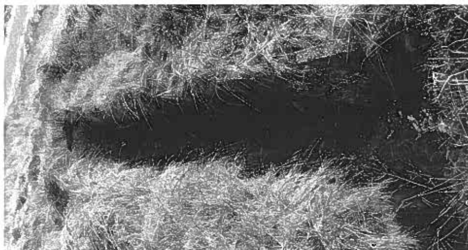
85 Den Helder-Huisduinen, Stelling van Den Helder, middelste loopgraaf, ± 1916 (in situatie nr. 6), aanzicht naar NO, foto 1986.
