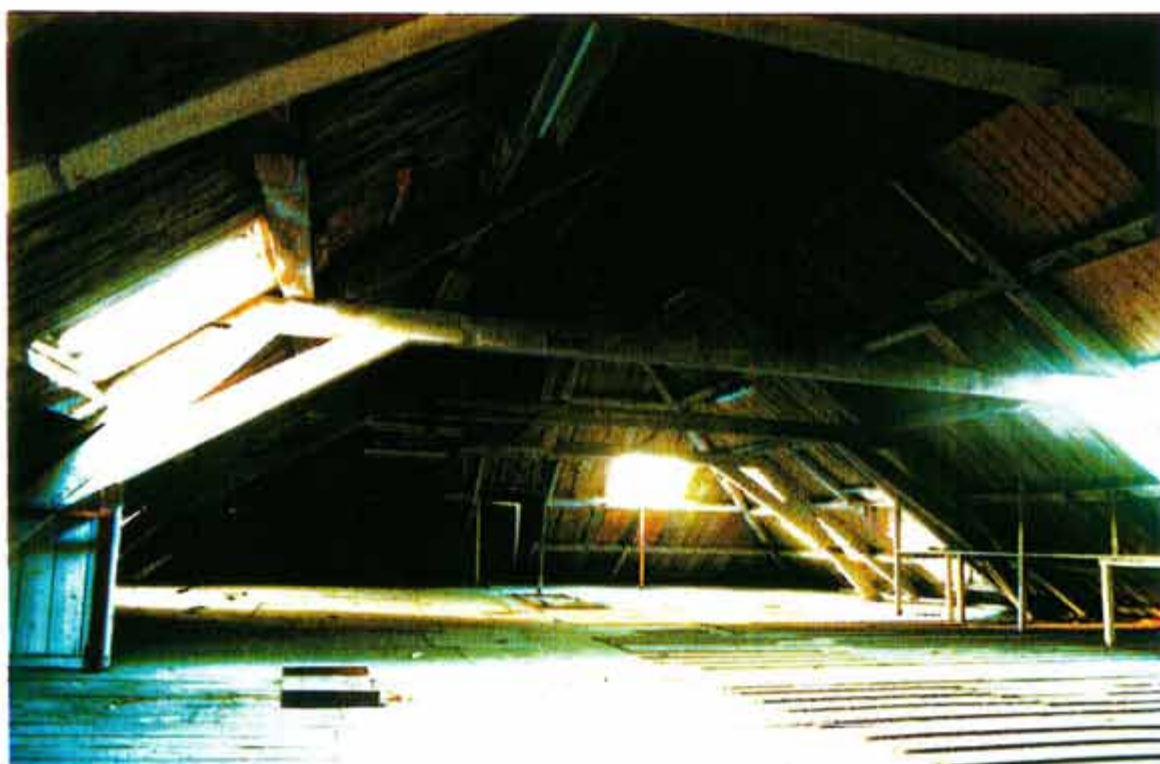
Afb. 27 Overzicht van de kapconstructie. De grenen kapconstructie bestaat uit een schaargebint met rechte spantbenen, waarop een A-spant is geplaatst. Het dak is nog voor een groot deel voorzien van origineel dakbeschot op gordingen. Naast de kapconstructie zijn ook de dakpellen met gordingen en dakbeschot nog grotendeels oorspronkelijk.
