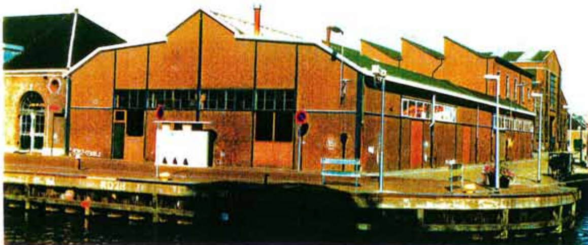
Afb. 32 Overzicht van de zuid-westhoek van de Slijperij, die ca. 1935 werd gebouwd. De gevel is opgebouwd uit een met baksteen gevuld staalskelet. De kapvorm is merkwaardig: een bijna pladak met afgeschuinde zijden en een lichtkap in het midden.
