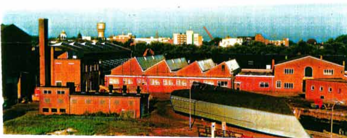
Afb. 36 Overzicht van het oostelijke deel van het complexe gebouw 60 gezien naar het westen. De noordelijke aanbouwen uit de dertiger jaren van de 20ste eeuw zijn voorzien van sheddaken en gedeeltelijk van bakstenen gevels en gedeeltelijk staalskelet met baksteenvullingen. De eenlaags aanbouw ervoor met kantoren is in 1947 gebouwd en in 1968 gewijzigd. Geheel rechts is gebouw 62 waarneembaar.
