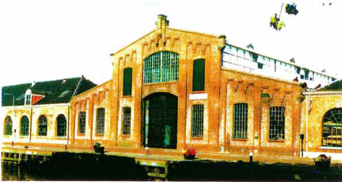
Afb. 29 Overzicht van westgevel van 'de Kathedraal' (zie afb. 7, 8 en 16). De classicistische bakstenen gevel is uitgevoerd met verdiepte velden en een klimmend fries met natuurstenen accenten. De bovenlichten van de gevel zijn geblindeerd en de lichtbeuk heeft gewijzigde vensters (zie afb. 30).
