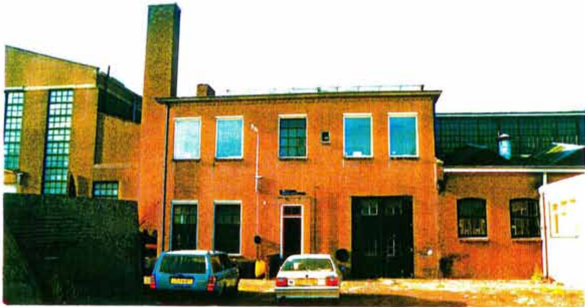
Afb. 42 Overzicht van de noordgevel van gebouw 'B' uit 1951, die sinds de bouw ongewijzigd is gebleven (zie afb. 12-14). De sobere gevel in baksteen heeft regelmatig geplaatste deuren en vensters en is langs de dakrand voorzien van een fries.
