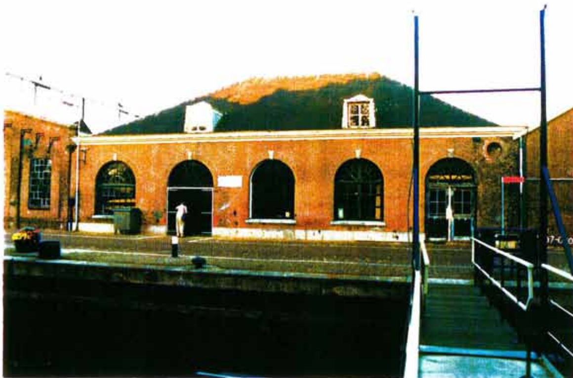
Afb. 21 Overzicht van het zuidelijk deel van de westgevel van het langwerpige gebouw (zie afb. 16). De gevel was oorspronkelijk voorzien van drie ramen op het zuidelijke uiteinde en verder alleen deuren. In 1861 is deze situatie ingrijpend gewijzigd (afb. 4).
