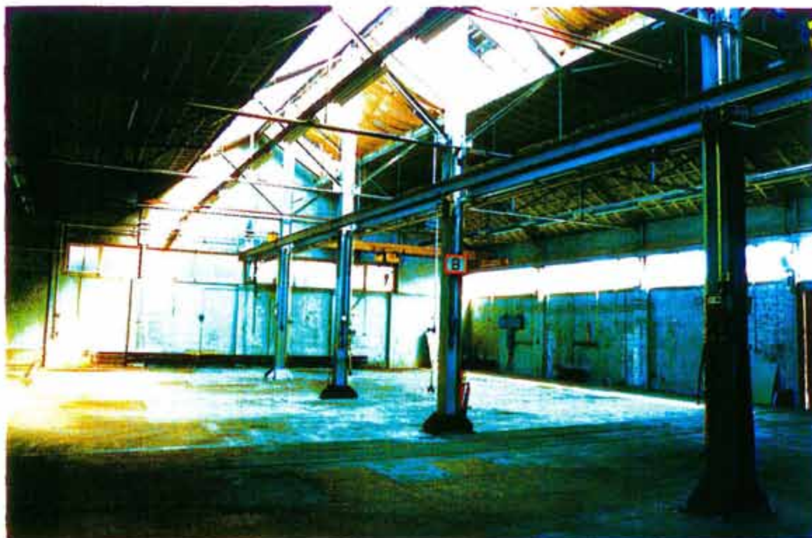
Afb. 33 Overzicht van het interieur van de voormalige appendage-werkplaats gezien naar het oosten (zie afb. 3). De werkplaats is voorzien van een geknikt samengesteld vakwerkspant op gewalste kolommen.
