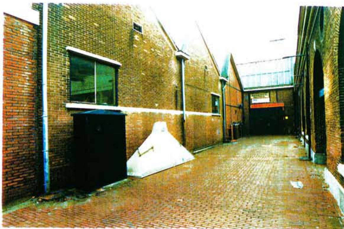
Afb. 37 Westgevel van de noordelijke aanbouw uit ca 1937. De aanbouw zal in twee fasen hebben plaatsgevonden: de twee zuidelijke hallen (hier één zichtbaar) zijn opgebouwd uit een staalskelet met baksteenvullingen, de twee noordelijke hallen hebben een betonskelet met baksteenmuren.
