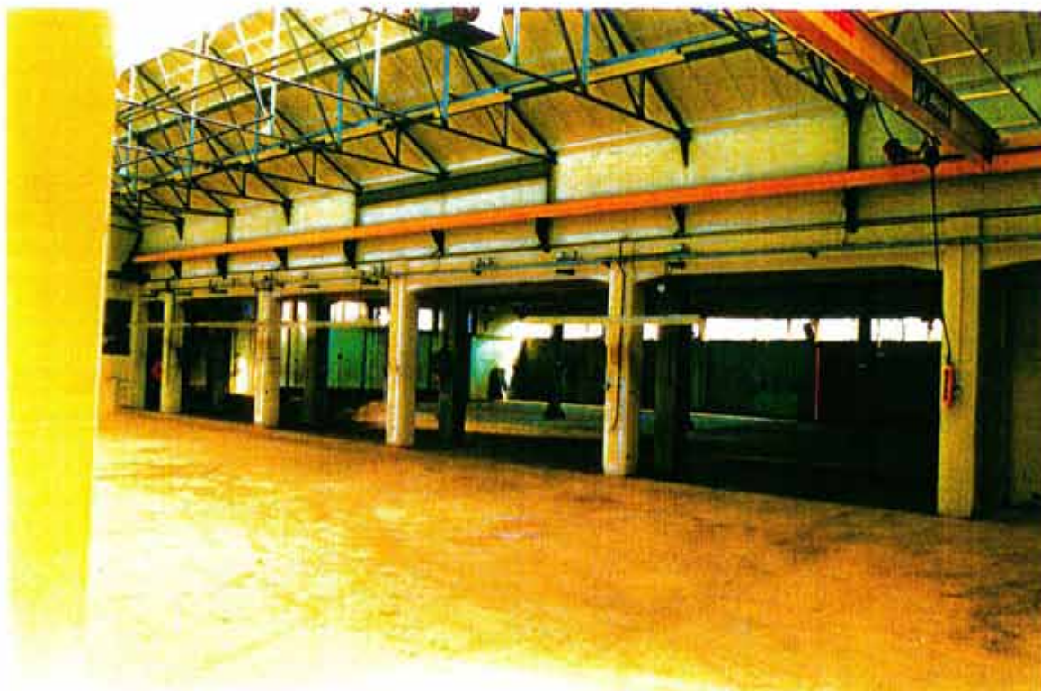
Afb. 35 Overzicht van het verbindingslid tussen de voormalige appendage- en assemblage werkplaats (zie afb. 3). In oorsprong stonden deze werkplaatsen als zelfstandige bouwdelen door een steeg gescheiden naast elkaar. In een later fase is deze steeg opgeheven en bij de werkplaatsen gevoegd. Naderhand zijn de kolommen vervangen in beton. Maar omdat de kapconstructie ongewijzigd bleef, herinnert de dubbele rij kolommen nog aan de steeg.
