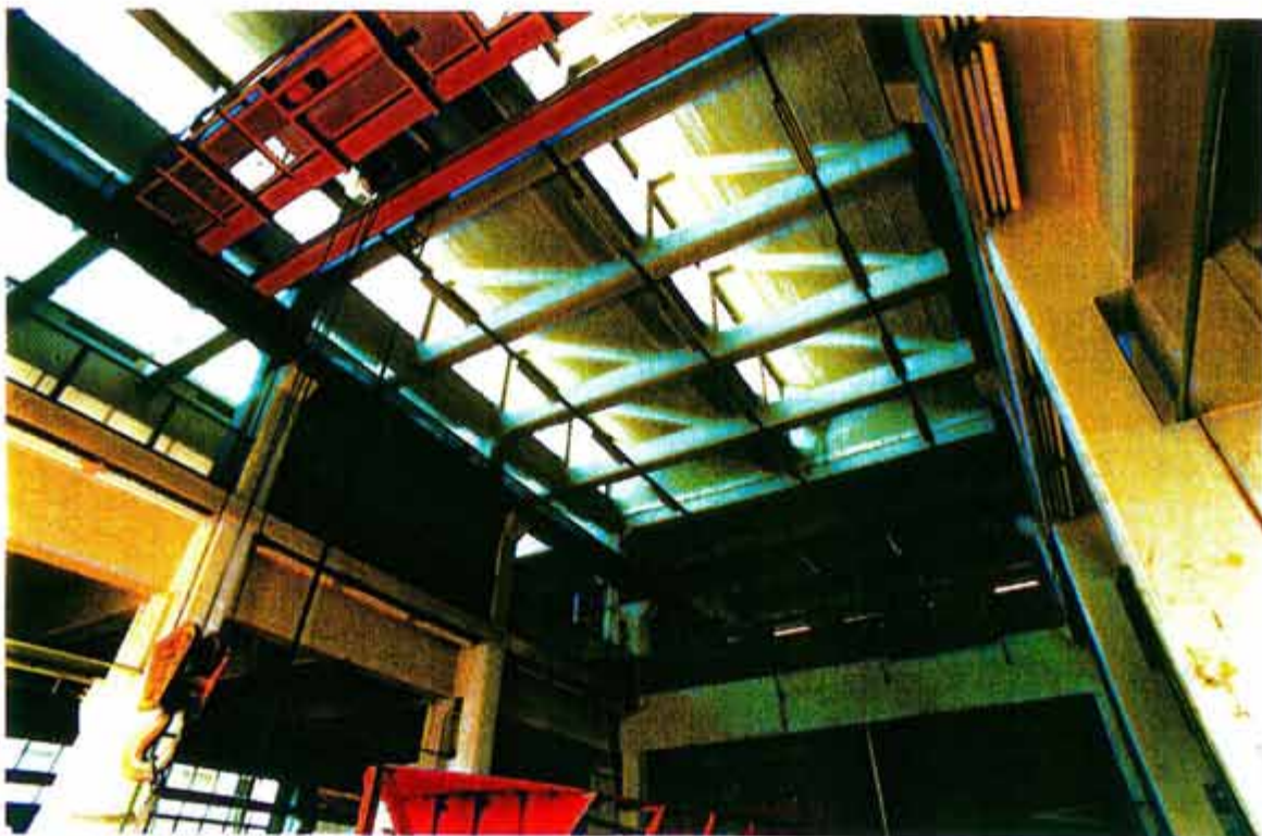
Afb. 43 Overzicht van het interieur van gebouw 'A' gezien naar het oosten. De werkplaats is voorzien van een betonnen draagstructuur met vide en van eveneens in beton uitgevoerde kasspannen in sheddak-vorm.
