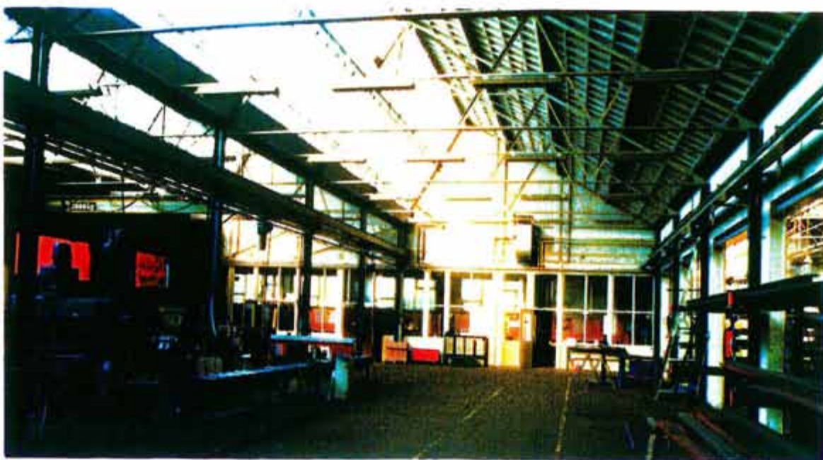
Afb. 38 De noordelijke aanbouw uit 1937, de twee zuidelijke hallen. Overzicht van het interieur van de voormalige bankwerkers-werkplaats gezien naar het oosten (zie afb. 3). De werkplaats is voorzien van een samengesteld vakwerkspant in sheddak-vorm op gewalste kolommen.
