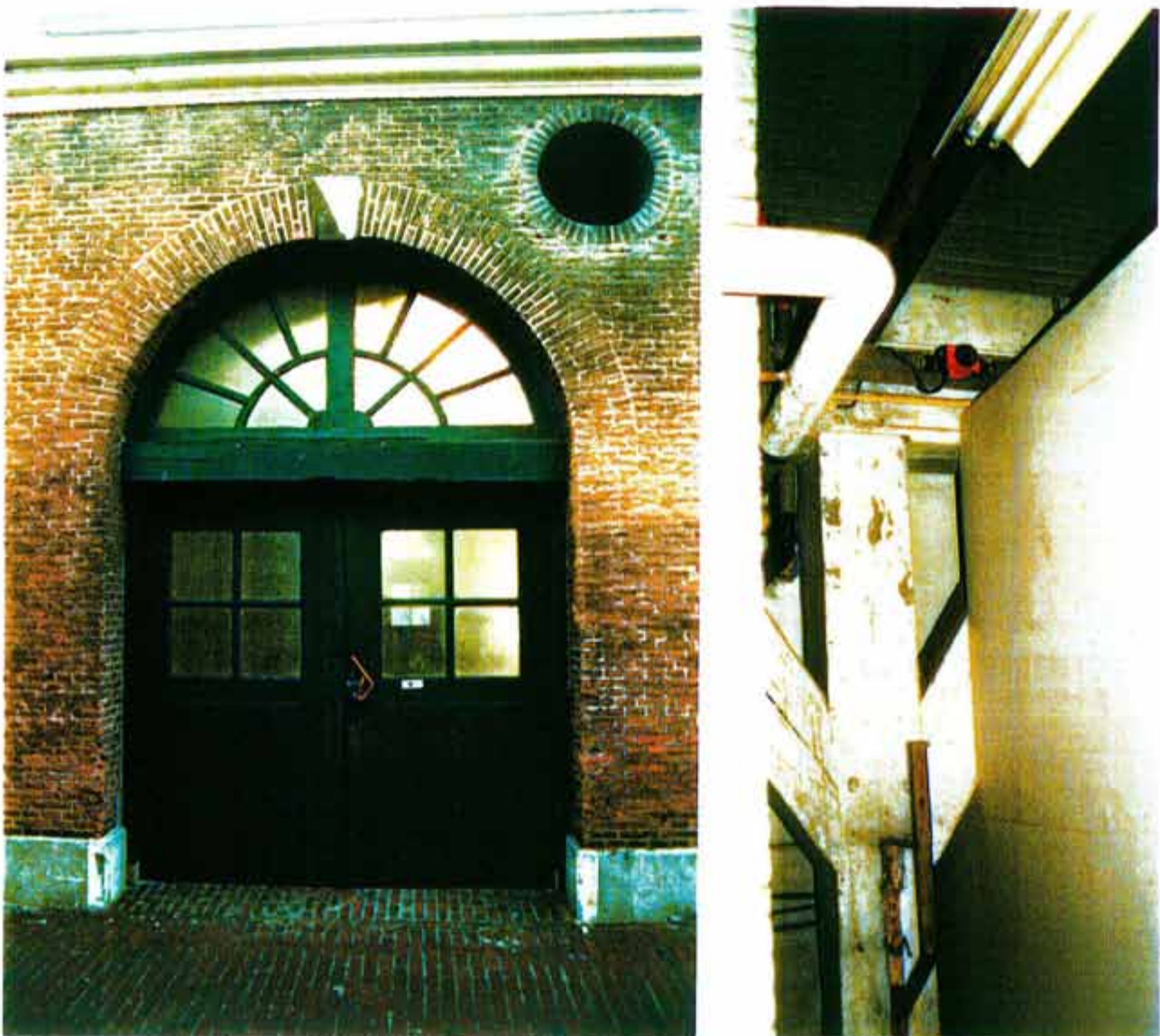
Afb. 25 (links) Overzicht van een vermoedelijk oorspronkelijke deur uit 1825. De dubbele deur met steens rondboog heeft een zware bovendorpel en daarboven een rondboogvormig bovenlicht met roede-indeling.
