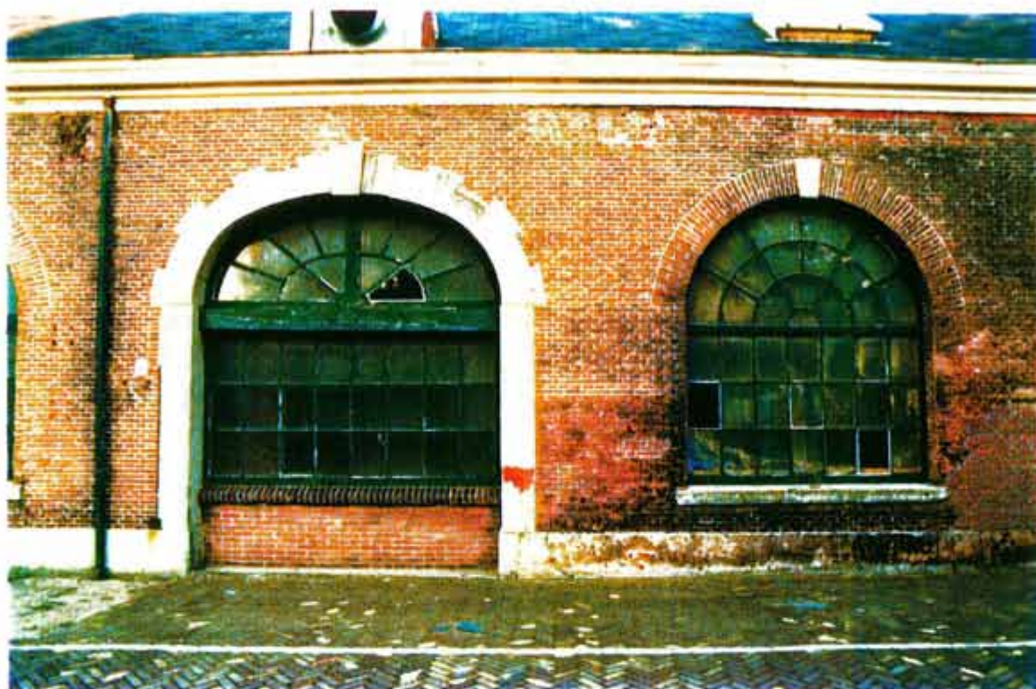
Afb. 20 Detail van het achtste en negende venster (vanuit het noorden gezien) van de westgevel. De voormalige achtste opening vanaf het noorden was in eerste opzet een deuropening. De deur was samen met de achtste deur uit het zuiden (verdwenen bij de aanleg van de Kathedraal) vanwege architectonische en symmetrische overwegingen geaccentueerd met een natuurstenen omlijsting om de eentonige rij van deuren enigszins te doorbreken.
