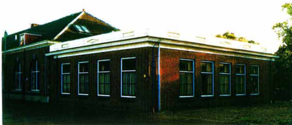
Afb. 22 Overzicht van de noordgevel en een deel van de oostgevel van de noordelijke aanbouw uit 1951 (zie afb. 10). De gevel gemetseld in kettingverband met regelmatig geplaatste vensters en een verhoogde kroonlijst is thans nog volledig conform de ontwerptekening uit 1951 (zie afb. 10). Een deel van de oostgevel en het schilddak van het langwerpige gebouw uit 1825 is eveneens zichtbaar (zie afb. 23-26).
