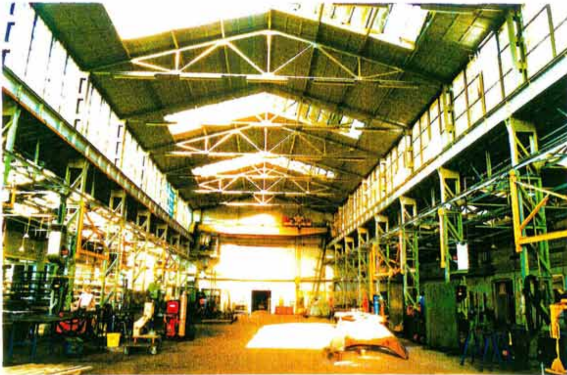
Afb. 31 Overzicht van de middenbeuk van de kathedraal gezien naar het oosten. In het gebouw is een geklonken ijzerconstructie met vakwerk-kolommen en spanten geplaatst. De kolommen zijn aan de bovenzijde voorzien van een vollwandligger waarover de loopkat (gedateerd 1917) beweegt.
