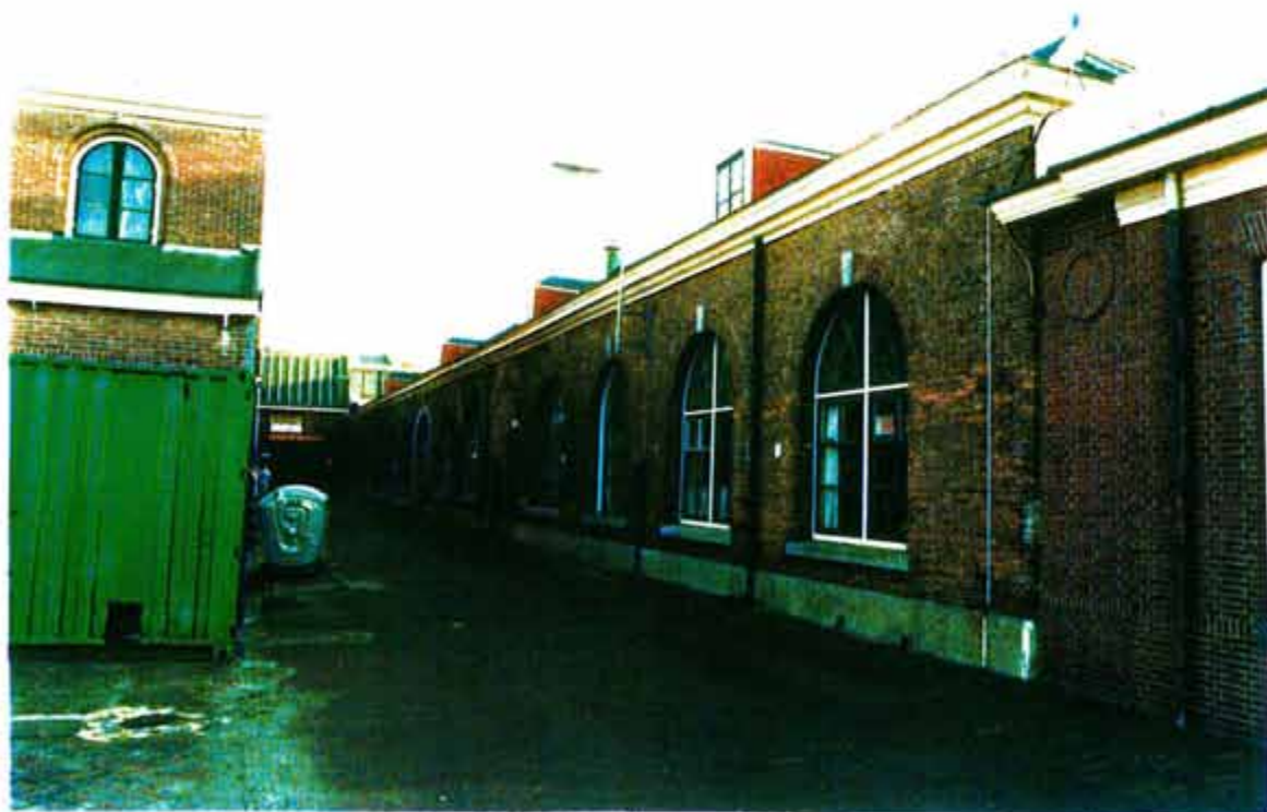
Afb. 23 Overzicht van de oostgevel van het langwerpige gebouw uit 1825 (zie afb. 16). De gevel had oorspronkelijk een indeling met voornamelijk deuren en slechts drie vensters op de beide uiteinden van de gevel (zie afb. 4 en 5).
