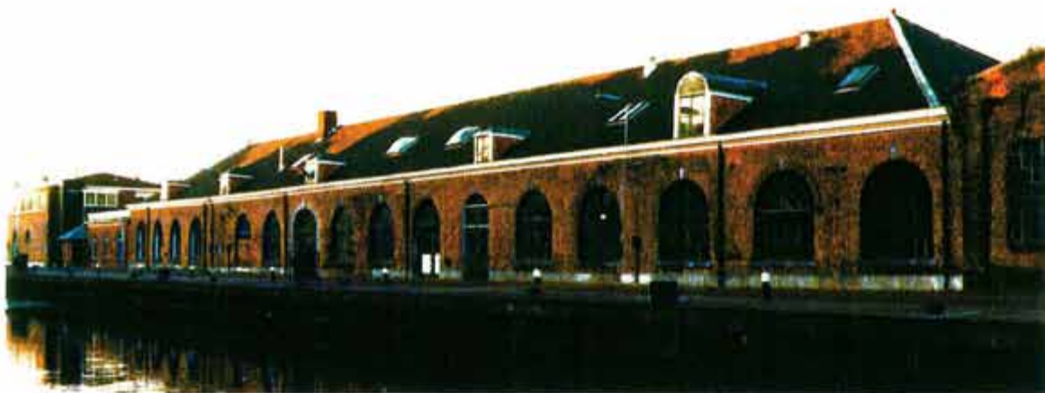
Afb. 19 Overzicht van de westgevel van het langwerpige gebouw (zie afb. 16). De gevel had oorspronkelijk een indeling met allemaal deuren en drie ramen op de beide uiteinden van de gevel (zie afb. 4 en 5). Enkele deuren hebben een natuursteenomlijsting om de eentonigheid van de gevel te doorbreken (zie afb. 20). Om dezelfde reden zijn enkele dakkapellen met een rond dak in plaats van een schilddak uitgevoerd (zie ook afb. 28). De deuren en vensters hebben aan de bovenzijde een steens rondboog met een natuurstenen sluitsteen. De sluitsteen heeft een diamantkop-ornament. Het oorspronkelijke venster van 1825 (en ook van 1861?) bestaat uit een kozijn met middenstijl en daarin geplaatst een raam met roede-indeling. Vele deuren zijn in 1861 gewijzigd in rondboogvensters (zie afb. 4).
