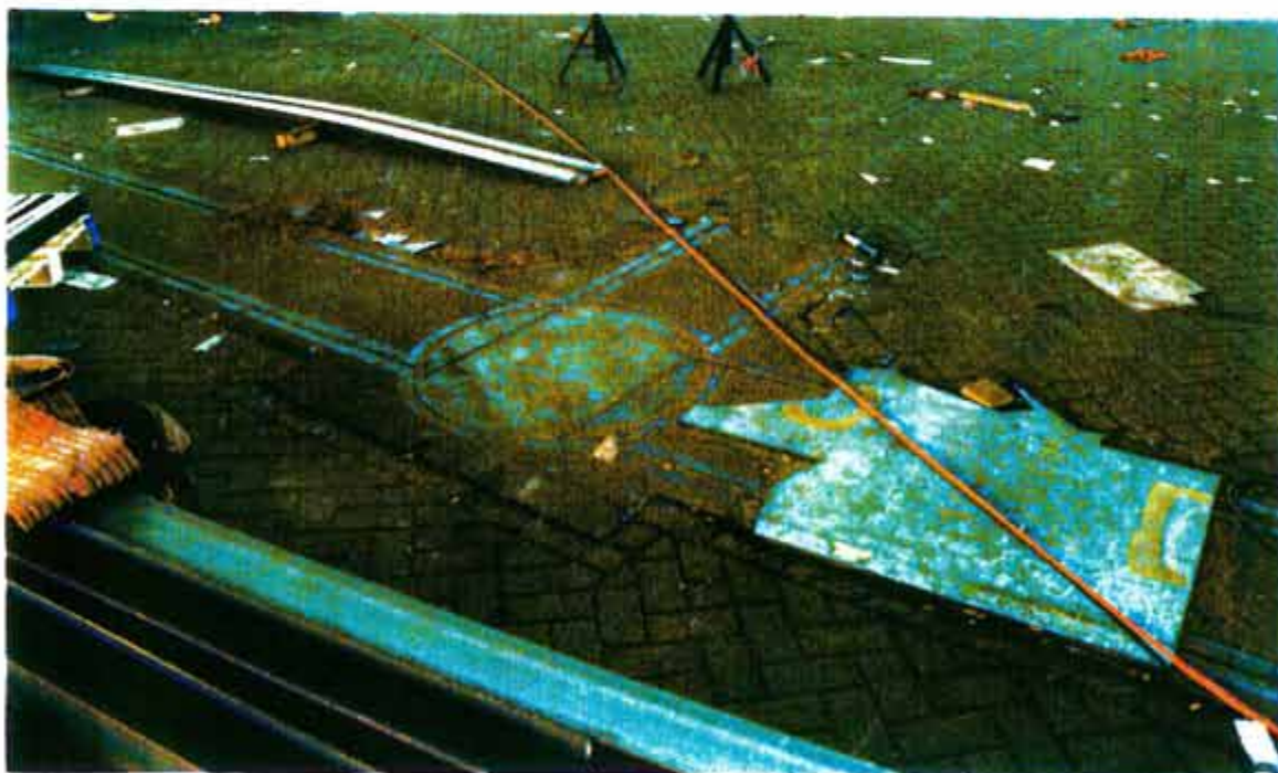
Afb. 34 Gebouw 60 is voorzien geweest van een smalspoortracée, dat onderdeel uitmaakte van een rail-netwerk op de Oude Rijkswerf (zie rapport Oude Rijkswerf, Historisch Overzicht en Groenvoorziening, afb. 9). Op enige plaatsen zijn restanten aanwezig zoals rails en draaiplateau's.
