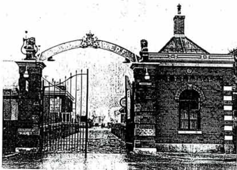
Afb. 10 De Westerpoort in 1962. Links is het ijzeren hek tussen de twee gemetselde kolommen zichtbaar. Boven de doorgang is een gebogen ijzeren plaat zichtbaar met het wapen van Nederland en de tekst "RIJKSWERF". Deze boog moet na de Tweede Wereldoorlog zijn aangebracht. Rechts staat het wachthuis uit 1857, dat is herbouwd in 1906. (Herkomst: Rijksdienst voor de Monumentenzorg, RdMz)
