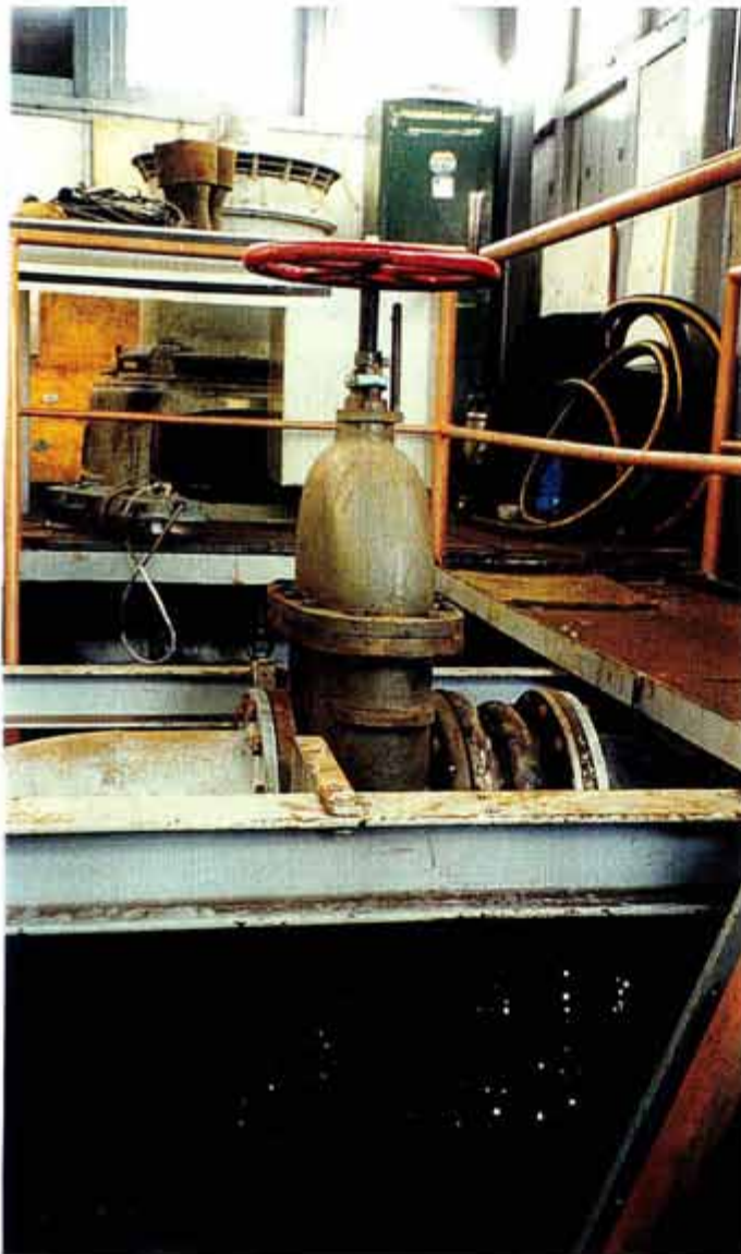
Afb. 21 (links) Regelklep van één van de zuigbuizen in het houten pomphuisje naast het Nieuwe Dok.
