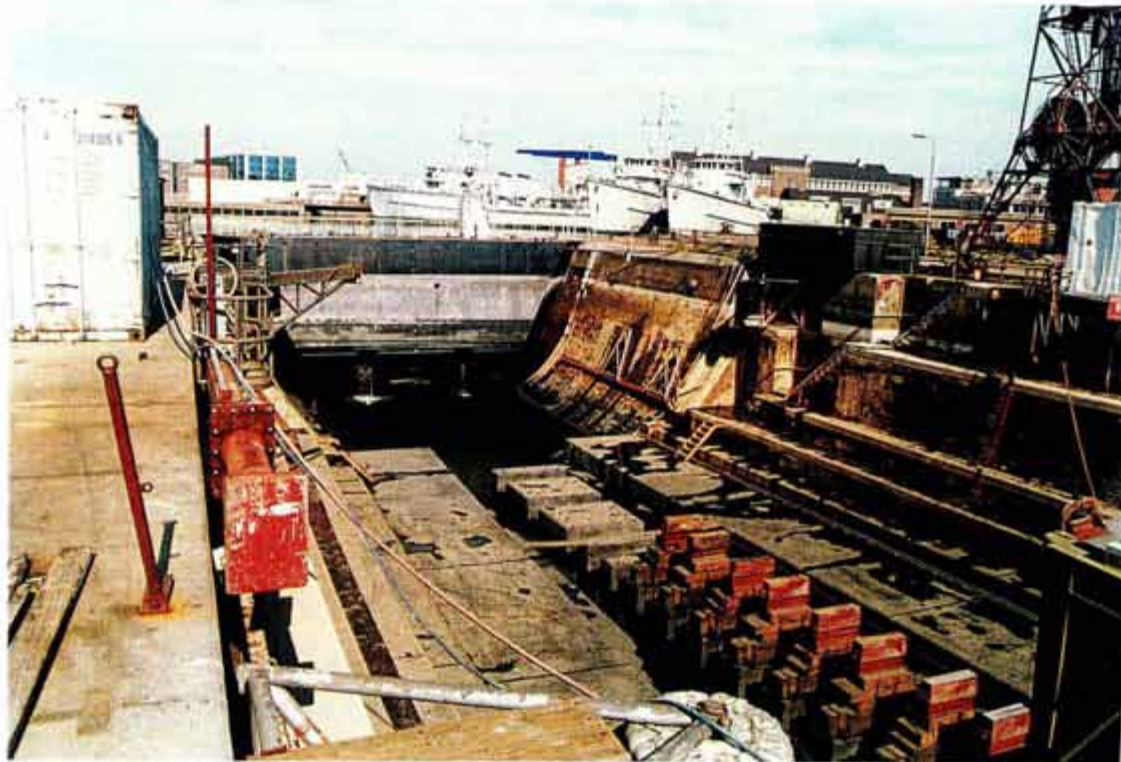
Afb. 11 (boven) Overzicht van het Nieuwe Dok, gezien naar het westen. Het dok dateert voornamelijk uit 1859-1866. De oude dokbodem is in 1966 vervangen door een nieuwe betonnen dokbodem. Toen zijn ook de verzwaringblokken aangebracht.
