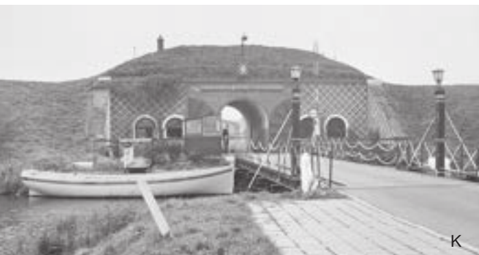
Erfrins: grootste fort van Nederland, als ingenieurswerk nog gaaf en herkenbaar.
