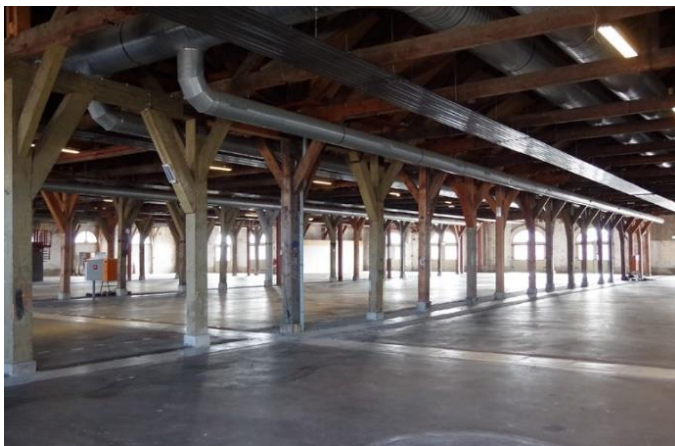
6 Interieur gebouw 66 gezien in zuidoostelijke richting.
