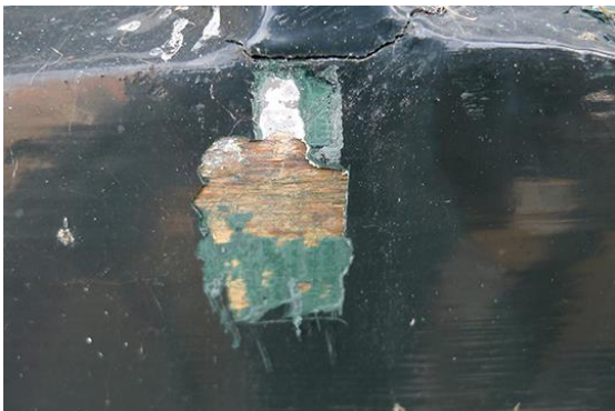
80 Het verfpakket op het raam van het bovenlicht bestaat uit een witte ondergrond (loodmenie?), grijze grondverf en twee lagen groene verf, waarbij de eerste laag lichter van kleur is.
