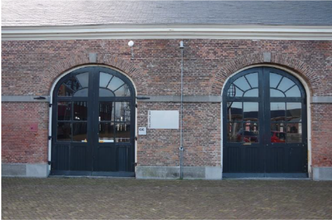
17 Twee bredere deuren zonder apart bovenlicht boven een kalf in de noordgevel. In de ontlastingsbogen een hardstenen sluitsteen. Dit geveldeel bevatte oorspronkelijk ook een dubbele deur met rondboog bovenlicht in het midden geflankeerd door een rondboog bovenlicht.
