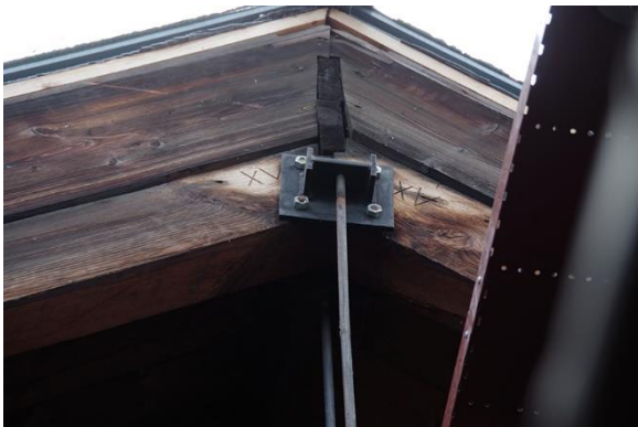
70 Gehakt telmerk XV in de nok van de spantconstructie.
