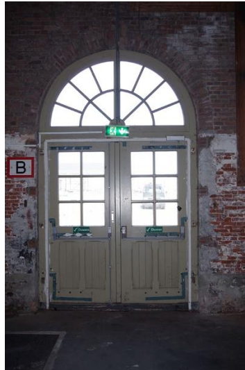
93, 94 en 95 De deuren waren oorspronkelijk grijs geschilderd (al dan niet een grondverf die aanvankelijk in het zicht was) zoals te zien op de plek waar het geheng oorspronkelijk bevestigd was en op een oude deur die bewaarde gebleven is.
