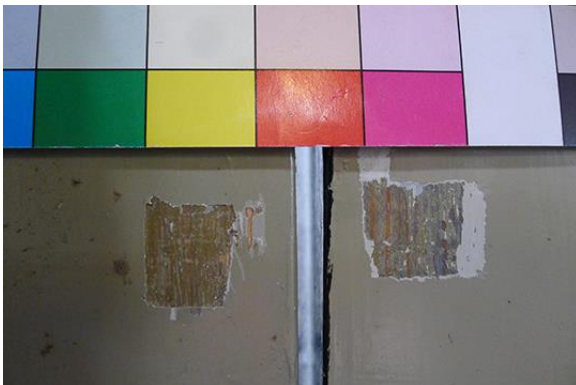
96 en 97 De deuren waren voorheen in een groenig grijze kleur geschilderd op een grijze grond- of verflaag. Thans hebben zij de dezelfde kleur als de donkere delen van het ingebouwde kantoor, een licht grijzig bruin / zandkleur.
