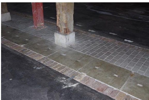
76 en 77 De huidige vloer bestaat uit een geluiddempende dekvloer (gasbeton met rubber?); de kabelgoten afgedekt met betonnen deksels liggen deels binnen een strook klinkers.
