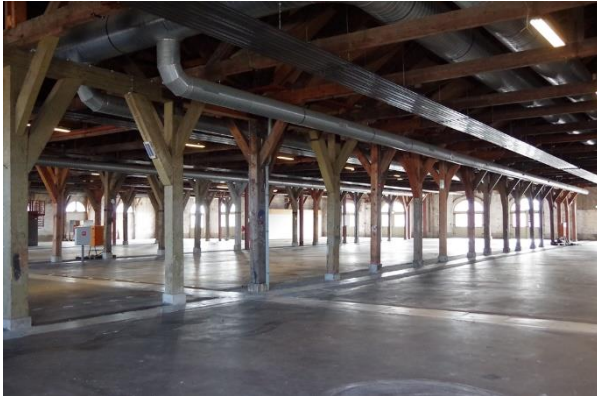
49 Interieur gezien vanuit het noordwesten. Van de standvinken is een aantal vernieuwd in 1997. 50 Interieur gezien vanuit het zuidoosten. In de beuk op de voorgrond (2 de vanuit het oosten) zijn tussen de houten stijlen van de constructie stalen portalen van een loopkatsysteem uit de jaren zeventig van de vorige eeuw bewaard gebleven.
