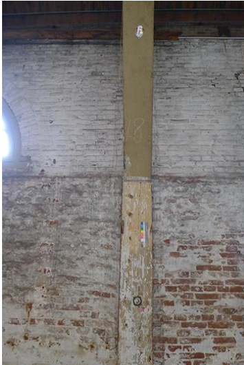
91 en 92 Op de stijlen en korbelen aangetroffen lichte okergele verf en groenig grijze verf.
