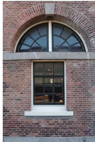
34 Westgevel gezien in zuidelijke richting. De gevel is voorzien van een hardstenen plint en cordonband.
