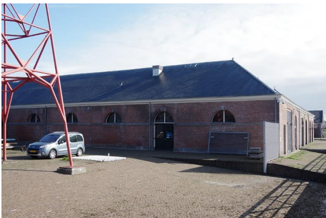
36 Zuidelijk uiteinde van de westgevel met rechts van de dubbele deur met bovenlicht een bij de restauratie in 1997 teruggebracht rondboogbovenlicht.
