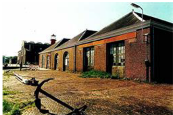
19 Linkerzijde zuidgevel voor restauratie 1997. De driedelige deur die oorspronkelijk geheel demontabel waardoor de opening in één keer geopend kon worden, dateert van na 1943. De stalen deur uiterst links behoort tot een trafo. (herkomst foto [redacted] en [redacted], 1997)
