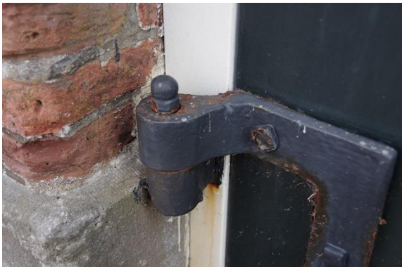
41 en 42 Duim van het zwaar uitgevoerd geheng van de deuren. Die met de afgeronde kop (appeltje) wordt onderaan toegepast en die met de uivormige beëindiging (peertje) bovenaan. Dit heeft zijn nut bij het inhangen van de deuren.
