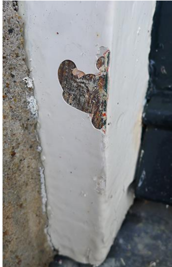
83 Detail verzwaarde middenstijl. Onder de witte verf is groene verf aangetroffen in meerdere lagen. De onderdorpel van het kozijn is met zink afgedekt.
