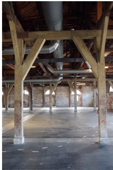
59 Interieur gezien in westelijke richting. Smalle travee zonder schoren met in het verlengde een venster.
