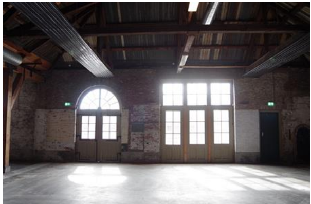
49 Interieur gezien vanuit het noordwesten. Van de standvinken is een aantal vernieuwd in 1997. 50 Interieur gezien vanuit het zuidoosten. In de beuk op de voorgrond (2 de vanuit het oosten) zijn tussen de houten stijlen van de constructie stalen portalen van een loopkatsysteem uit de jaren zeventig van de vorige eeuw bewaard gebleven.
