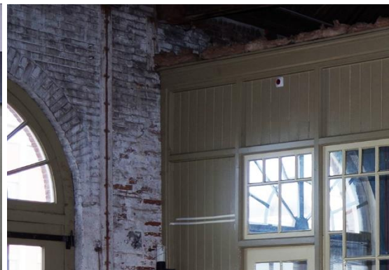
96 en 97 De deuren waren voorheen in een groenig grijze kleur geschilderd op een grijze grond- of verflaag. Thans hebben zij de dezelfde kleur als de donkere delen van het ingebouwde kantoor, een licht grijzig bruin / zandkleur.
