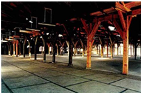
74 Vloer van steltonplaten. (herkomst foto [redacted] en [redacted], 1997).
