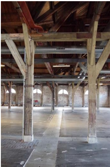
59 Interieur gezien in westelijke richting. Smalle travee zonder schoren met in het verlengde een venster.
