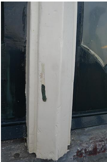
83 Detail verzwaarde middenstijl. Onder de witte verf is groene verf aangetroffen in meerdere lagen. De onderdorpel van het kozijn is met zink afgedekt.
