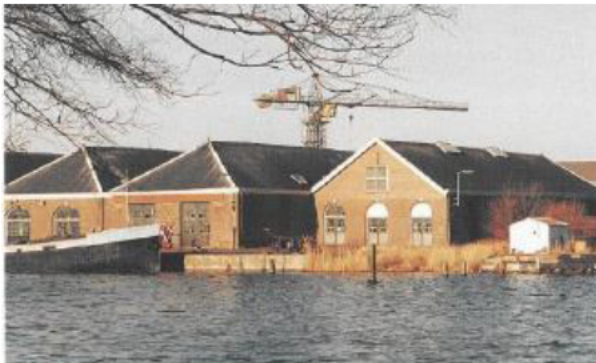
18 Overzicht zuidgevel 1995. (herkomst foto Hangelbroek Gouweter Architecten, 1997 [?])
