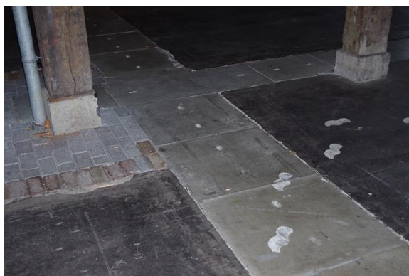
76 en 77 De huidige vloer bestaat uit een geluiddempende dekvloer (gasbeton met rubber?); de kabelgoten afgedekt met betonnen deksels liggen deels binnen een strook klinkers.
