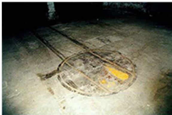
74 Vloer van steltonplaten. (herkomst foto [redacted] en [redacted], 1997).
