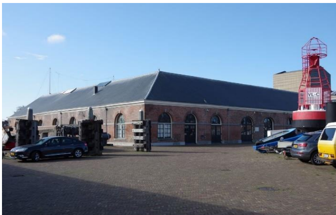
3 Gebouw 66 gezien vanuit het noordoosten.
