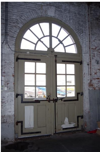
93, 94 en 95 De deuren waren oorspronkelijk grijs geschilderd (al dan niet een grondverf die aanvankelijk in het zicht was) zoals te zien op de plek waar het geheng oorspronkelijk bevestigd was en op een oude deur die bewaarde gebleven is.
