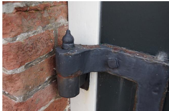
41 en 42 Duim van het zwaar uitgevoerd geheng van de deuren. Die met de afgeronde kop (appeltje) wordt onderaan toegepast en die met de uivormige beëindiging (peertje) bovenaan. Dit heeft zijn nut bij het inhangen van de deuren.
