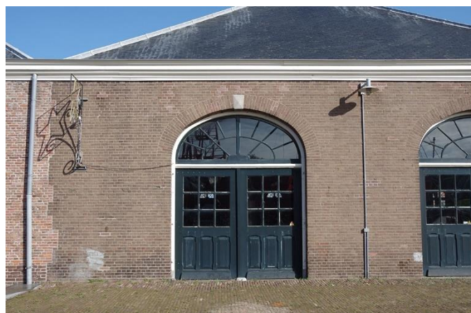
26 Dubbele deur met rondboog bovenlicht zonder verzwaarde middenstijl in linker (west)beuk in de oorspronkelijke breedtemaat. In de ontlastingsboog ontbreekt de hardstenen sluitsteen.
