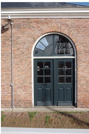
26 Dubbele deur met rondboog bovenlicht zonder verzwaarde middenstijl in linker (west)beuk in de oorspronkelijke breedtemaat. In de ontlastingsboog ontbreekt de hardstenen sluitsteen.
