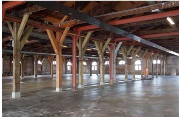
49 Interieur gezien vanuit het noordwesten. Van de standvinken is een aantal vernieuwd in 1997. 50 Interieur gezien vanuit het zuidoosten. In de beuk op de voorgrond (2 de vanuit het oosten) zijn tussen de houten stijlen van de constructie stalen portalen van een loopkatsysteem uit de jaren zeventig van de vorige eeuw bewaard gebleven.
