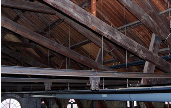
68 Geklonken stalen liggers als vervanging van houten dekbalken.
