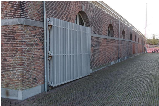
34 Westgevel gezien in zuidelijke richting. De gevel is voorzien van een hardstenen plint en cordonband.
