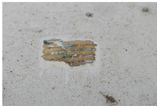
80 Het verfpakket op het raam van het bovenlicht bestaat uit een witte ondergrond (loodmenie?), grijze grondverf en twee lagen groene verf, waarbij de eerste laag lichter van kleur is.
