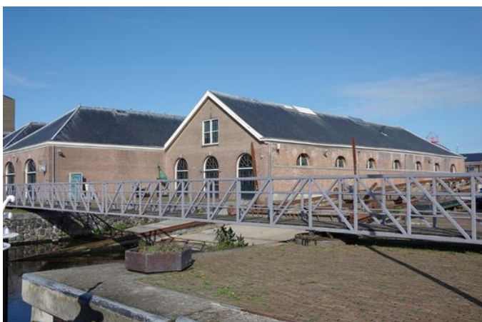
4 Gebouw 66 gezien vanuit het zuidoosten.
