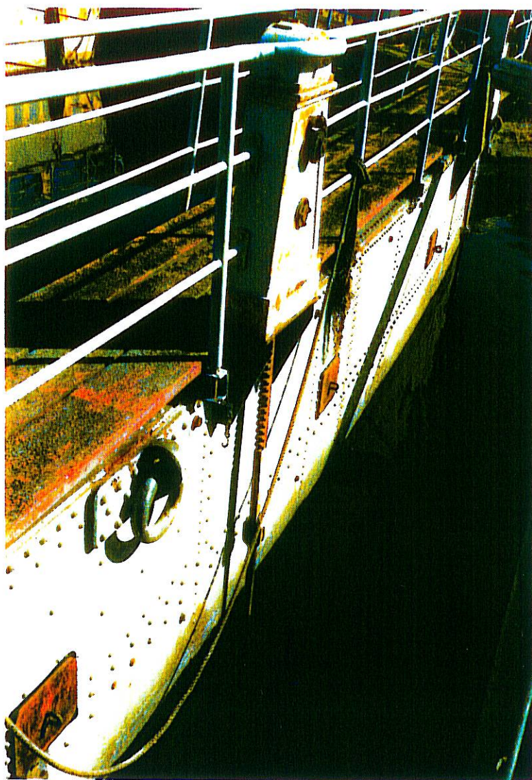
Afb. 13 Bedieningszuil voor een schuif in één van de sluisdeuren, die vermoedelijk uit circa 1925 dateren. De detaillering is anders dan aan de oorspronkelijke sluisdeuren (vergelijk afb. 8 en 9). De sluisdeuren zijn ofwel in enigszins gewijzigde vorm nog grotendeels oorspronkelijk, ofwel later vernieuwd (omstreeks 1925?).
