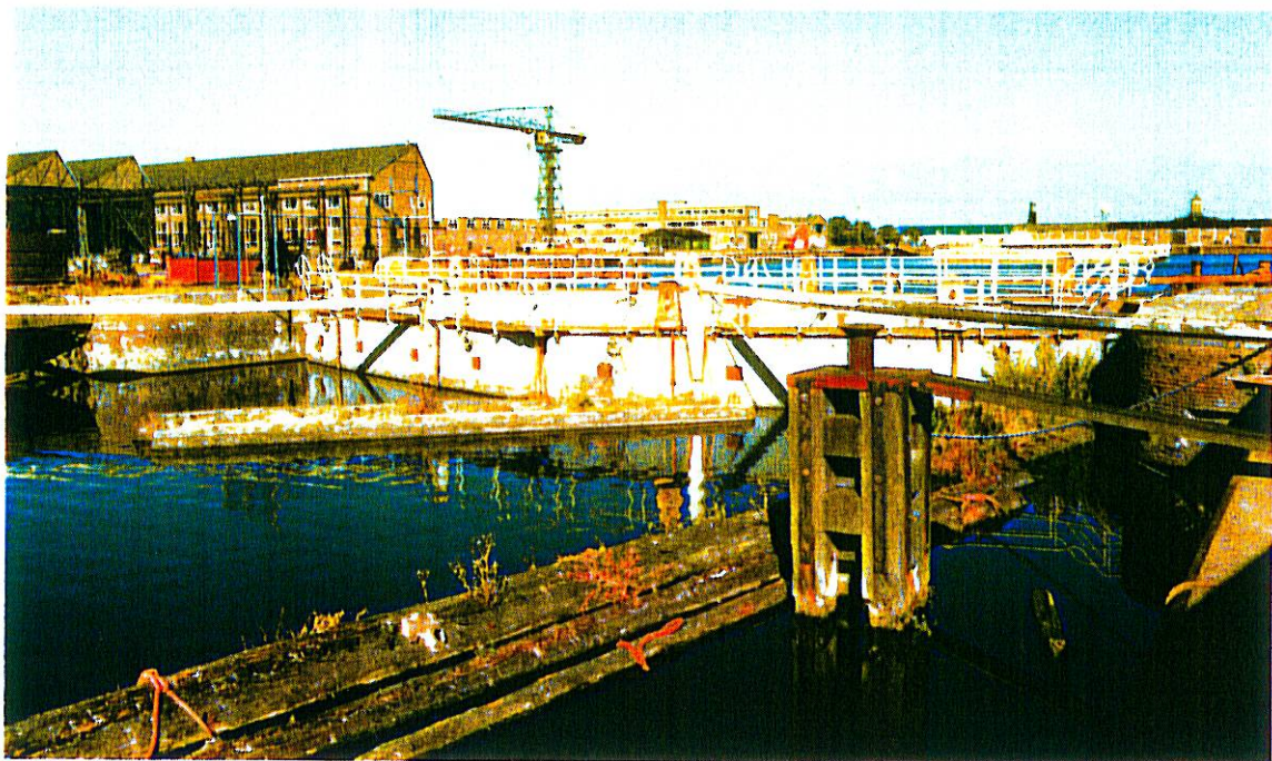
Afb. 11 (boven) Overzicht van de sluis in het dokkanaal uit 1859-1861, gezien van het dak van gebouw 72. De sluisdeuren zijn ofwel in enigszins gewijzigde vorm nog grotendeels oorspronkelijk, ofwel later vernieuwd (omstreeks 1925?).
