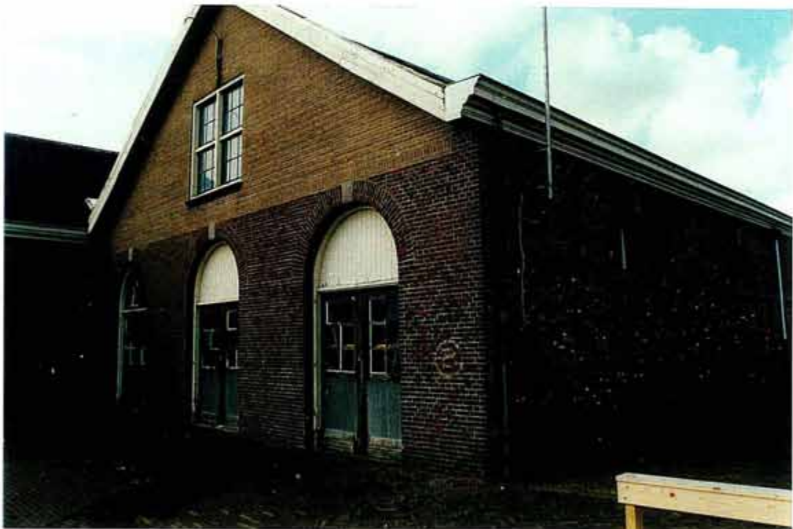
Afb. 12 Overzicht van de zuidgevel van de oostbeuk. Deze gevel is in 1888 teruggelegd. De penant (A) behoort bij de verbouwing van 1952 (zie afb. 3). Penant (B) behoort bij de verbouwing van 1915 (zie afb. 1). De twee penanten (C) dateren uit één periode en zijn te dateren tussen de verbouwing uit 1915 en 1952. De geveltop (D) is als laatste vervangen, de datering hiervan is onbekend, maar is zeker jonger dan de verbouwing van 1954.
