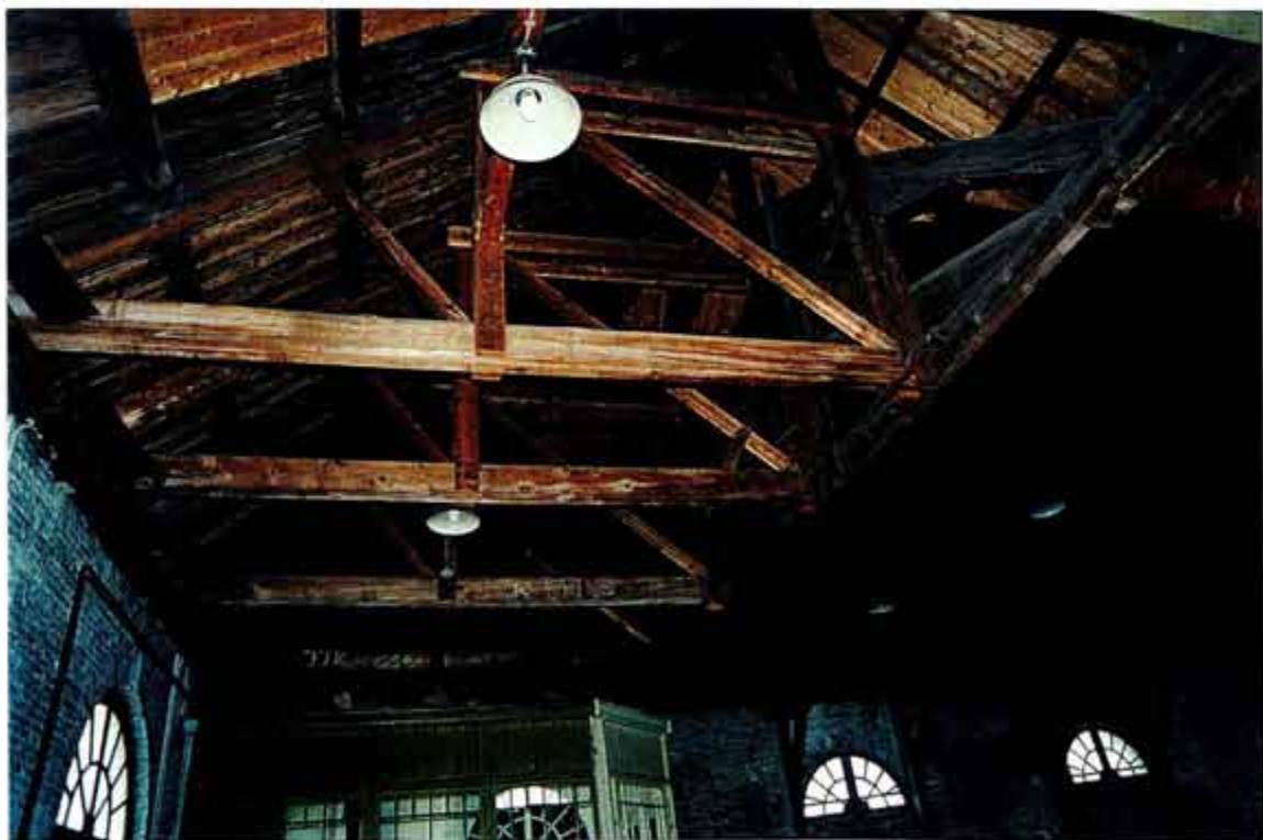
Afb. 19 Overzicht, in oostelijke richting, van een gedeelte van de later aangebrachte langskap van de noordgevel. De langskap bestaat uit vervangen halfspanten. Het halfspant bestaat uit een ligger, een stijl, een dakligger en schoren. De halfspanten staan tegen het eerste spant aan van het oorspronkelijke schilddak.
