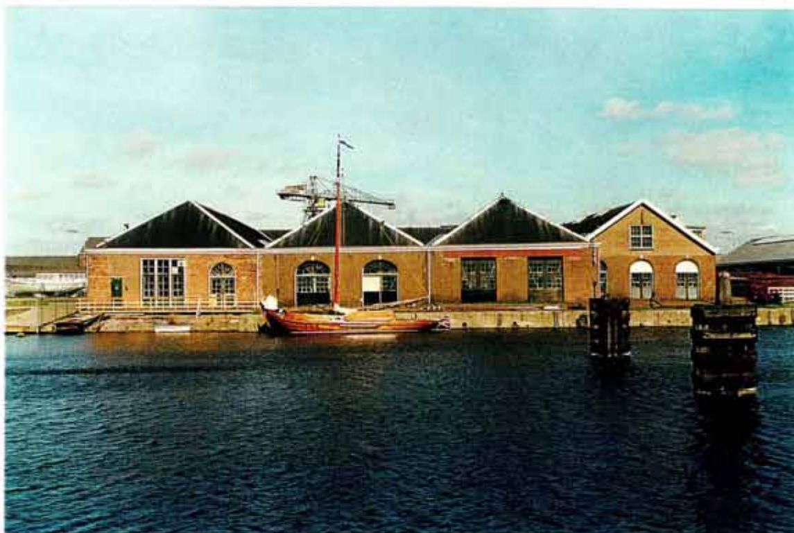
Afb. 11A Overzicht van de zuidgevel. De westelijke beuk (links) heeft nog een scheepshelling. De zuidgevel van de westelijke beuk is in 1943 vernieuwd, het middelste deel is nog jonger. De tweede beuk, gezien van links bevat muurwerk van 1915, net als de derde beuk, maar daar zijn de rondboogdeuren in 1947 vervangen. De zuidgevel van de rechterbeuk is in 1888 teruggelegd; de gevel is tussen 1915 en 1952 vernieuwd; de top van de gevel is na 1954 vernieuwd.
