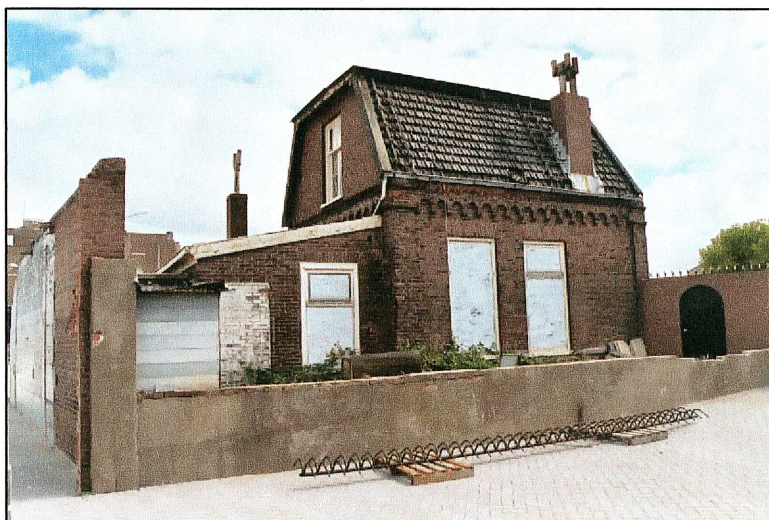
Afb. 7: Achterzijde met voormalige achtermuur en aan- en verbouwingen.
