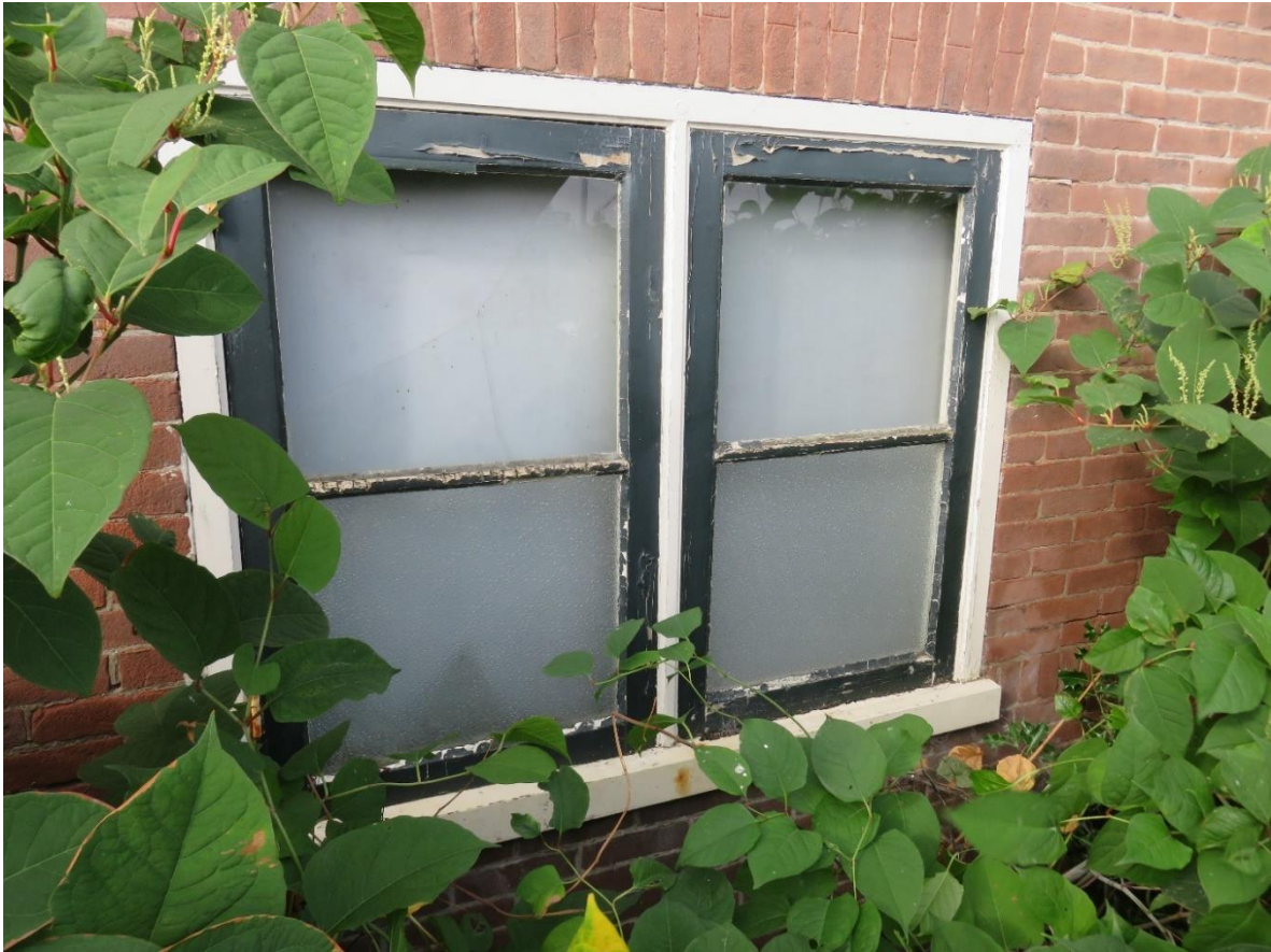
13 – Detail gevelopening rechterzijgevel aanbouw
