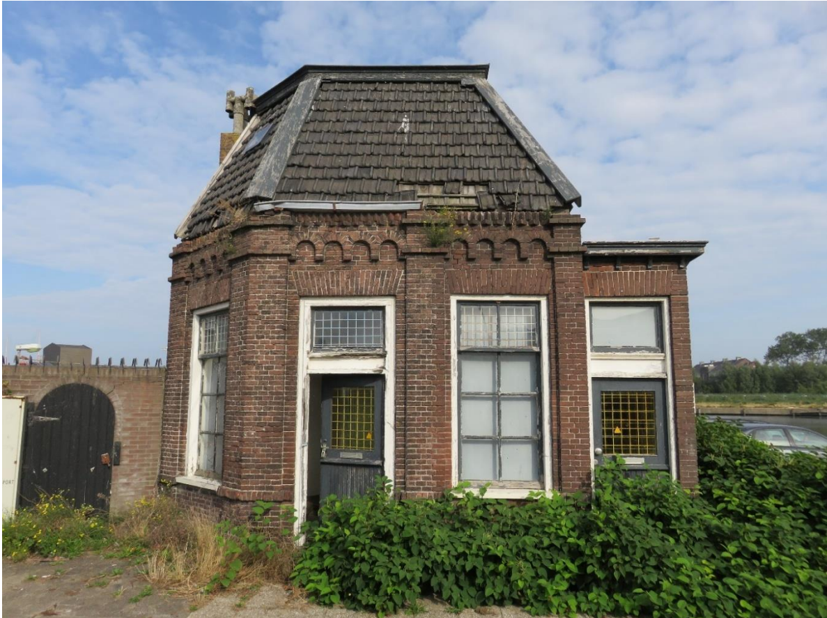
9 - Voorgevel brugwachtershuisje, in noordelijke richting
