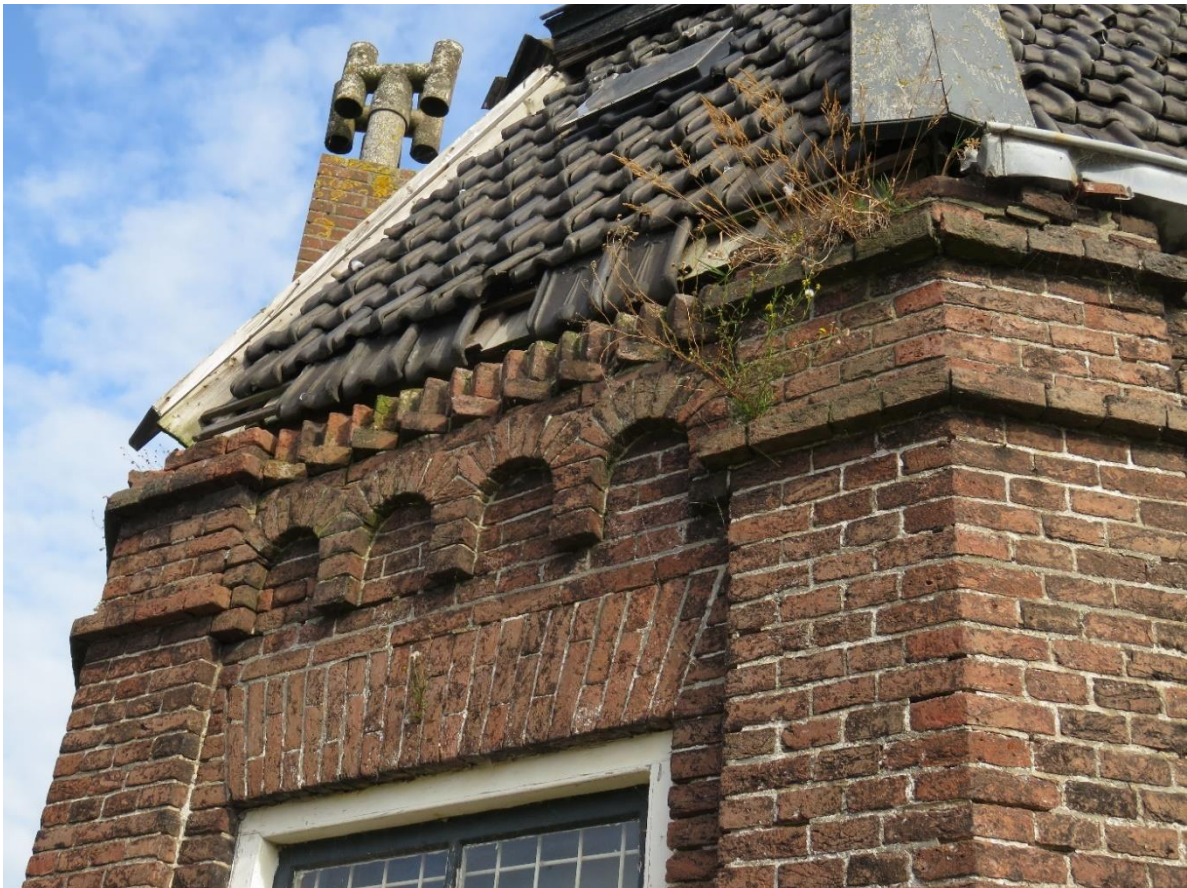
10 - Detail linker travee voorgevel brugwachtershuisje, met verbijzondering in het metselwerk
