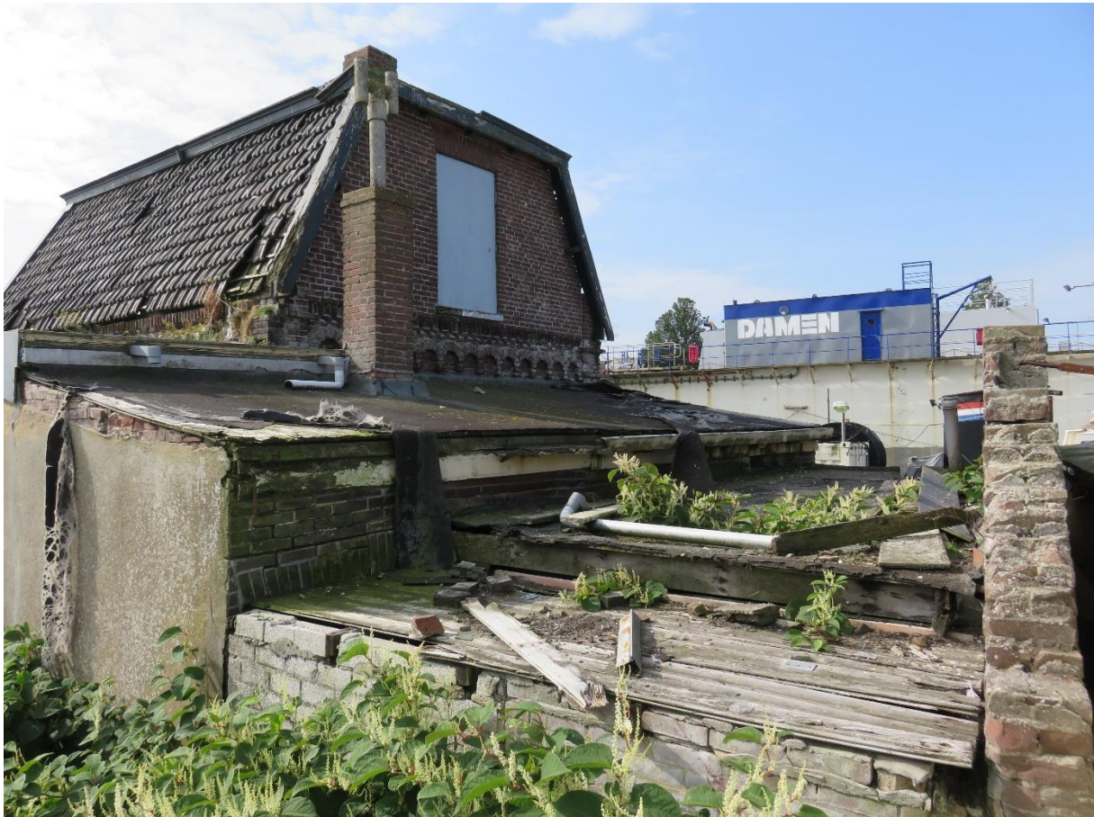
14 – Achtergevel brugwachtershuisje met latere aanbouwen. Van links naar rechts: de aanbouw met lessenaarsdak uit 1875-1910, de latere aanbouwen met plat dak uit 1978 en het restant van de oude muur op het naastgelegen perceel
