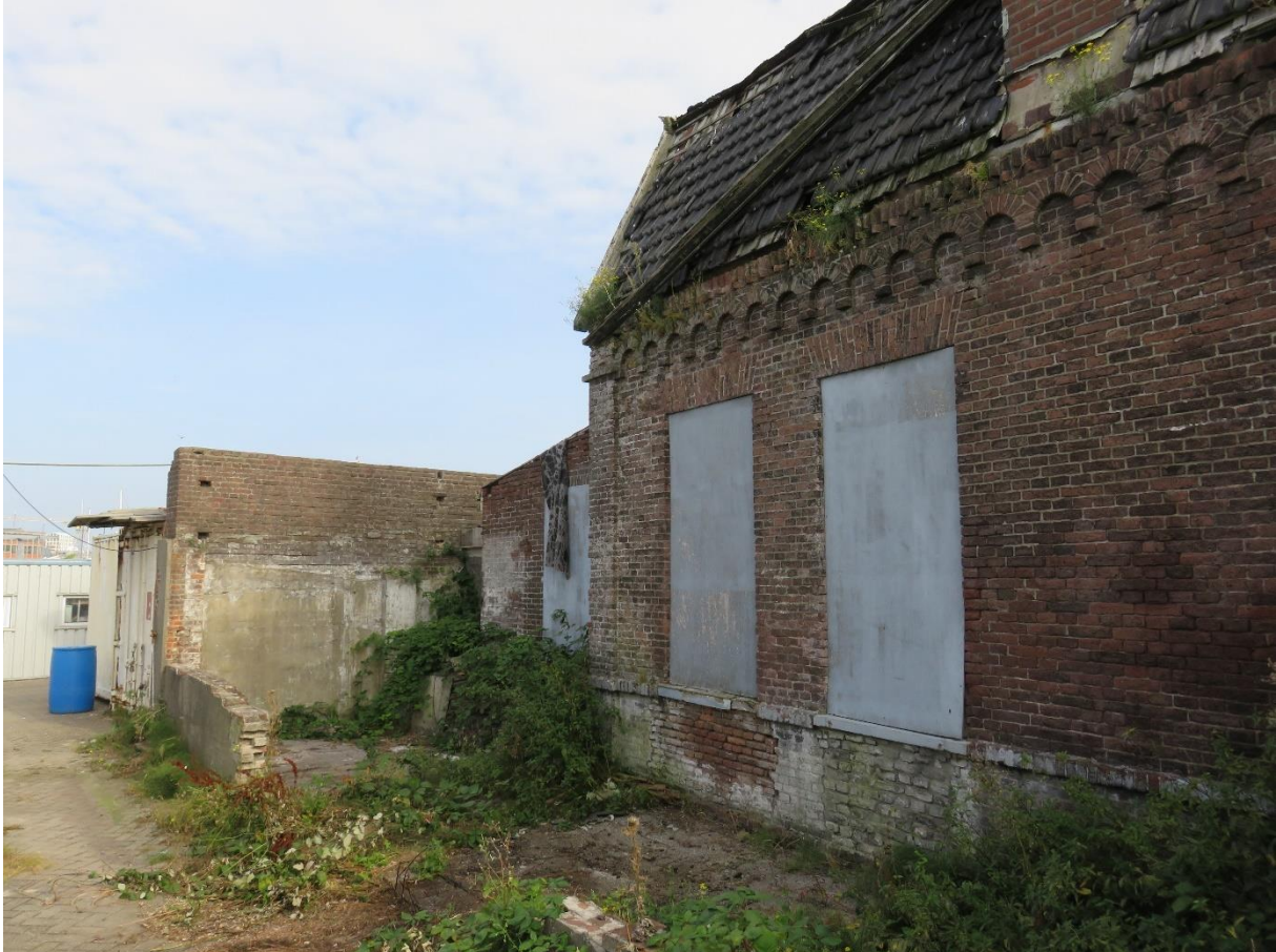
11 – Linkerzijgevel brugwachtershuisje, met aan de achterzijde de latere aanbouwen
